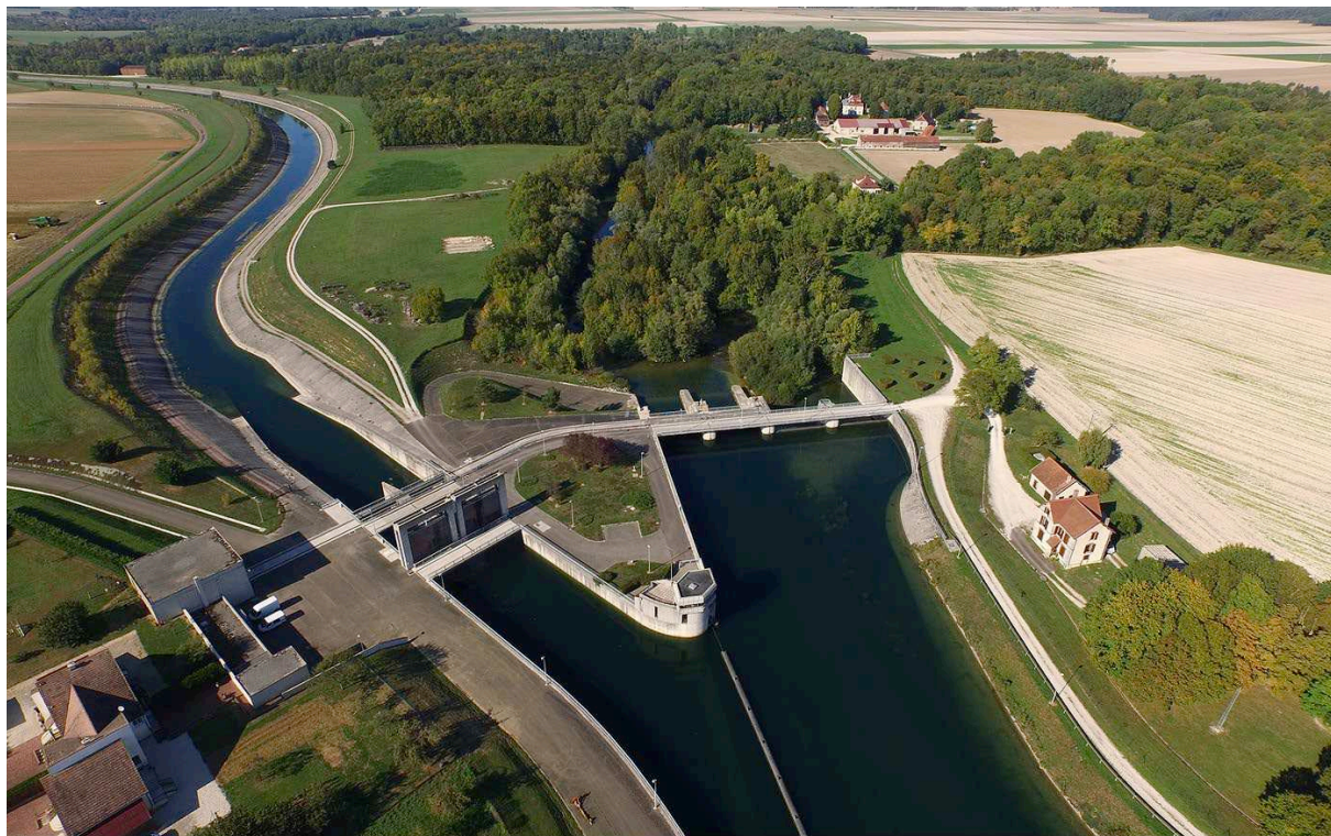
Figure 232 : Canal d'amenée, lac-réservoir Aube - Source : © Emmanuel JF Riche / EPTB Seine Grands Lacs.
