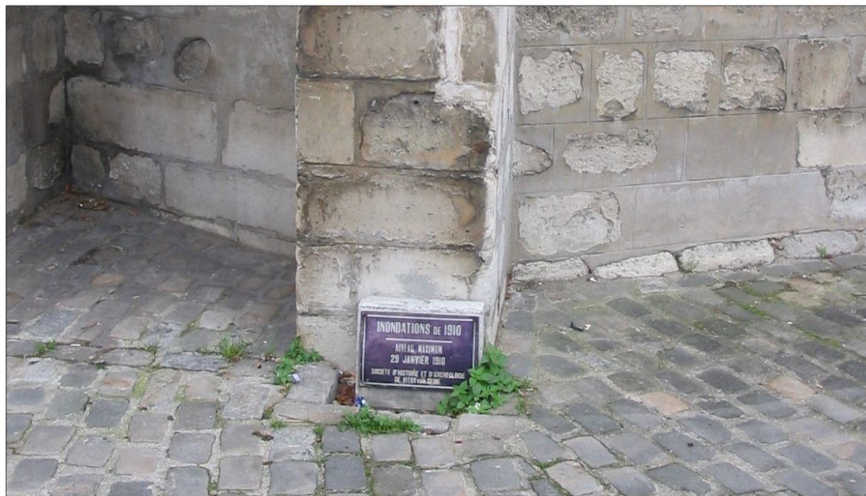
Figure 210 : Repère de crue 1910, église de Vitry-sur-Seine, Vitry-sur-Seine - Source : DIREN IDF, SPC SMYL.
