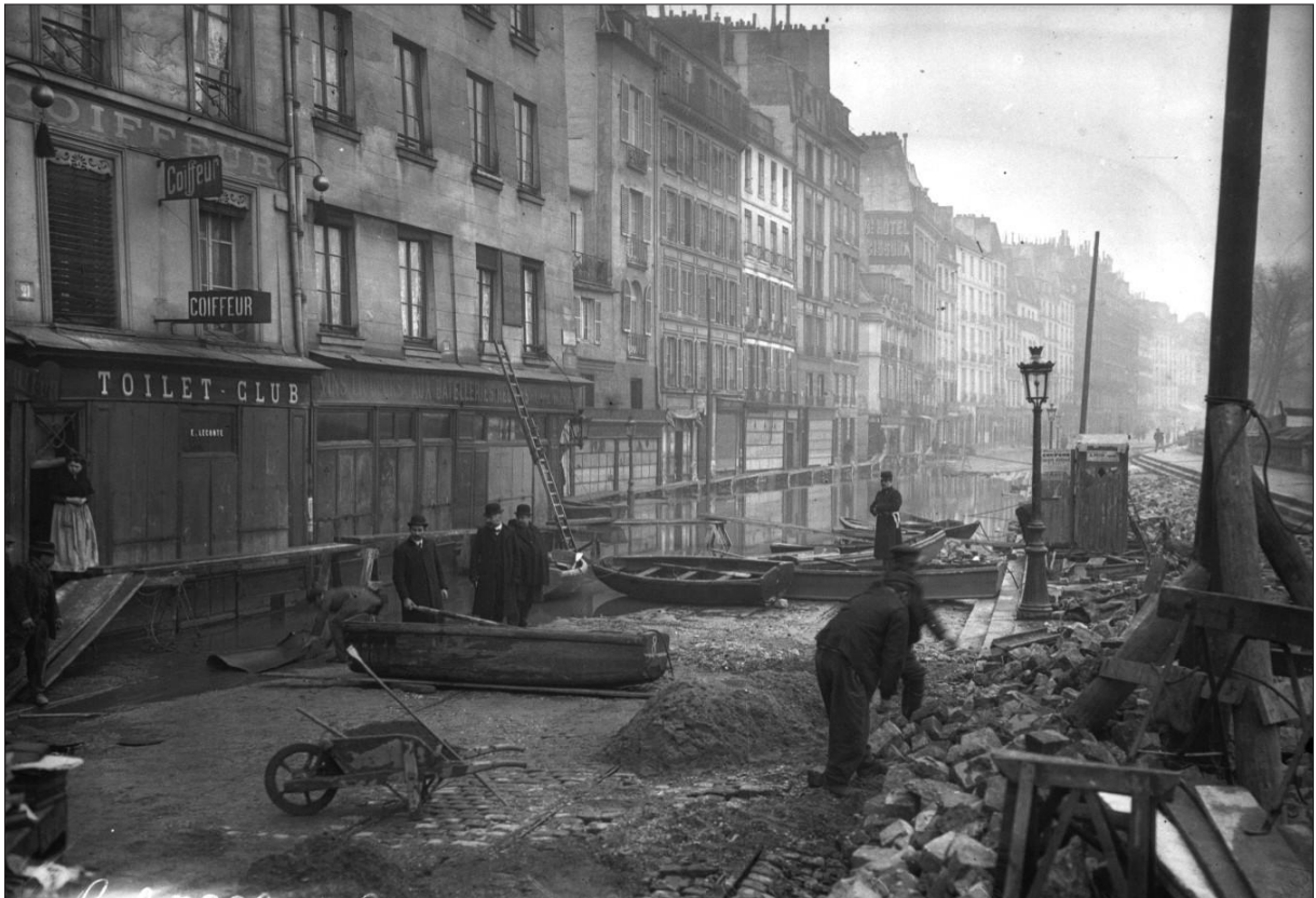
Figure 200 : 1910, quai des Grands Augustins, inondations de Paris, 6e arrondissement, dégâts après la décrue : photographie de presse, Agence Rol - Source : gallica.bnf.fr /Bibliothèque Nationale de France.
