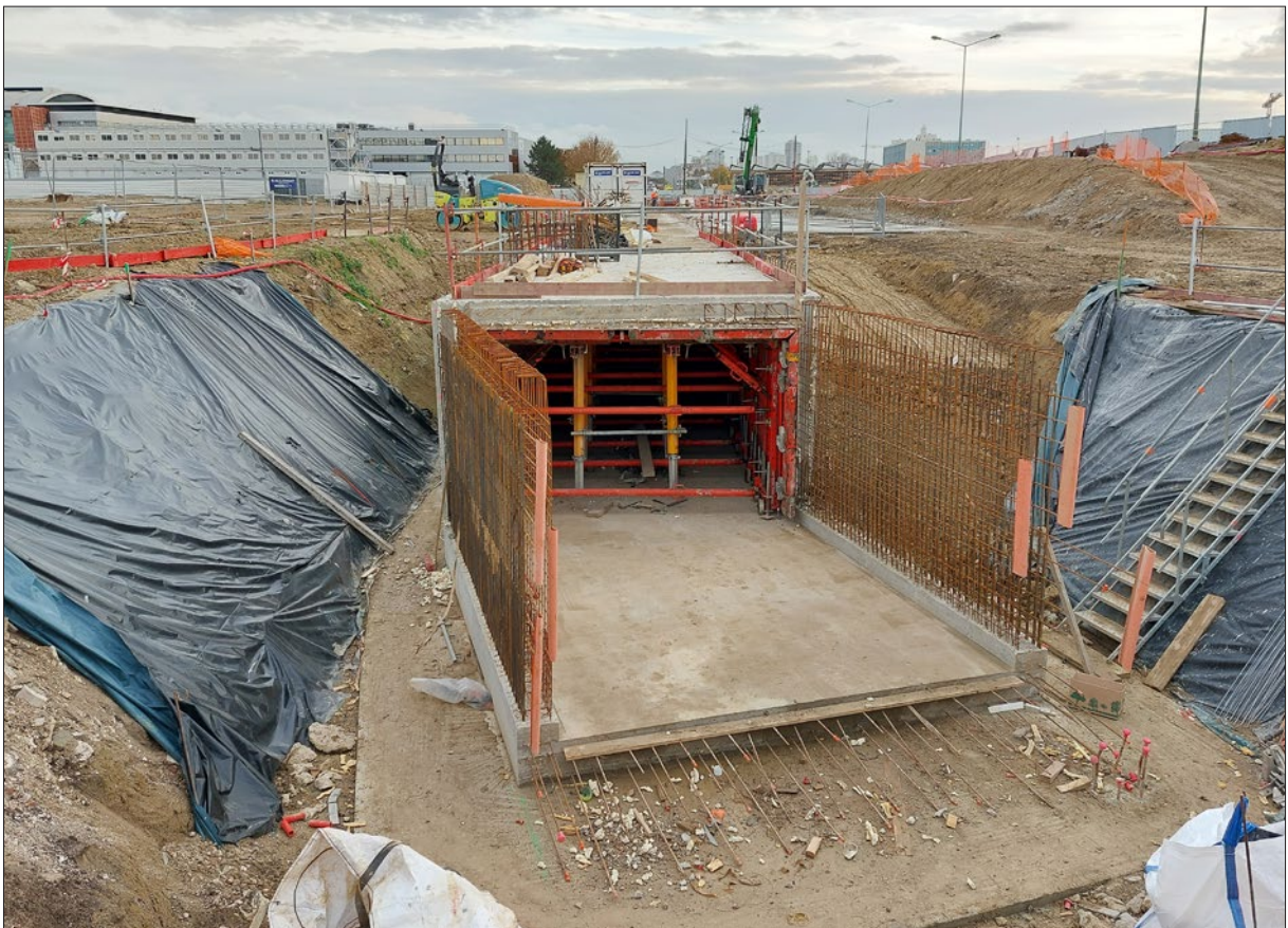
Figure 279 : Mise en œuvre cadre hydraulique, ZAC Gare-Ardoines - Source : Benoît Yacine, Novembre 2021.
