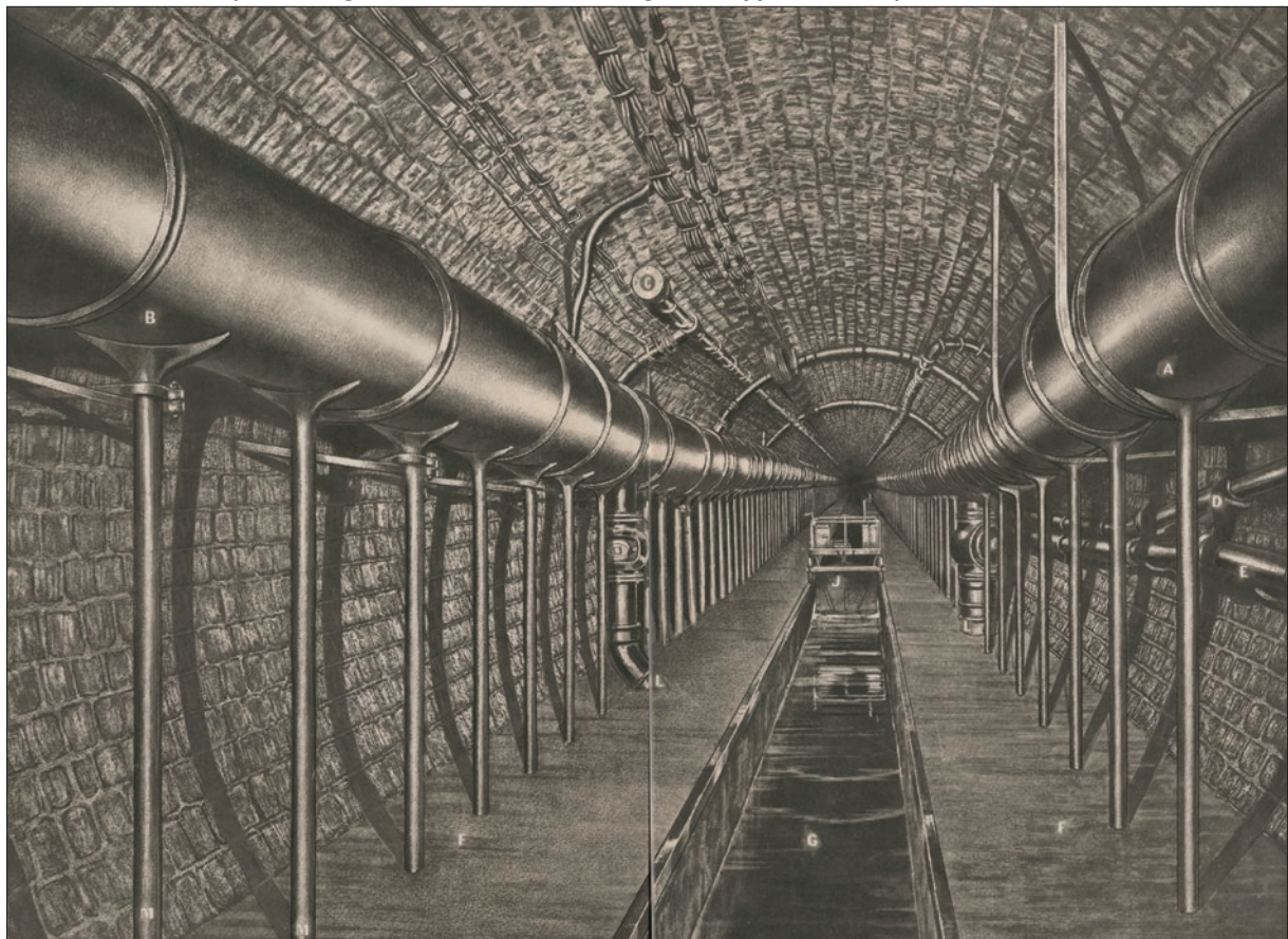
Figure 198 : Égouts collecteurs de Paris , vue perspective de la galerie du boulevard Sébastopol ; Les travaux souterrains de Paris, TLAS, Tome 5, par M. Belgrand, 1872- 1887 - Source : gallica.bnf.fr /Bibliothèque Nationale de France.
