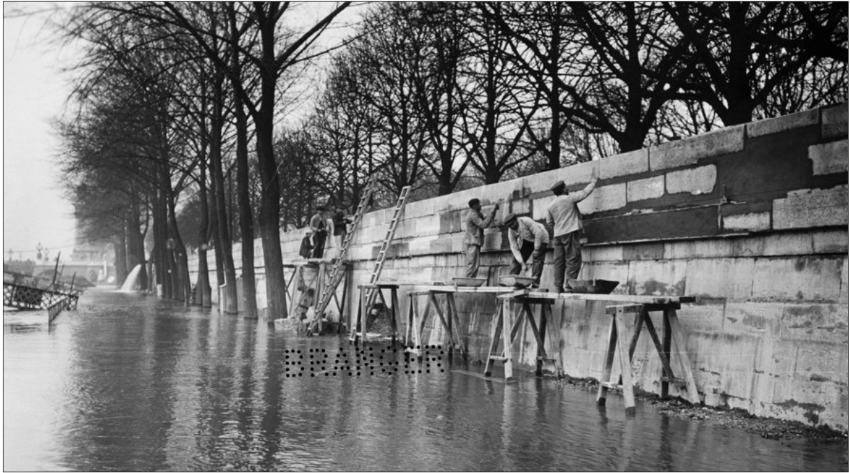
Figure 206 : Crue de la Seine, rehaussement du quai des Tuileries, Paris 1910 - Source : © Maurice-Louis Branger / Roger-Viollet.
