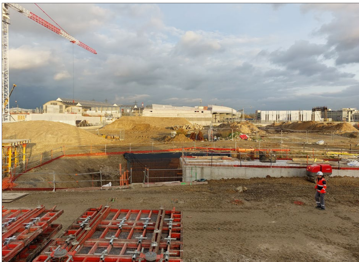
Figure 277 : Mise en œuvre cadre hydraulique, ZAC Gare-Ardoines - Source : Benoît Yacine, Novembre 2021.
