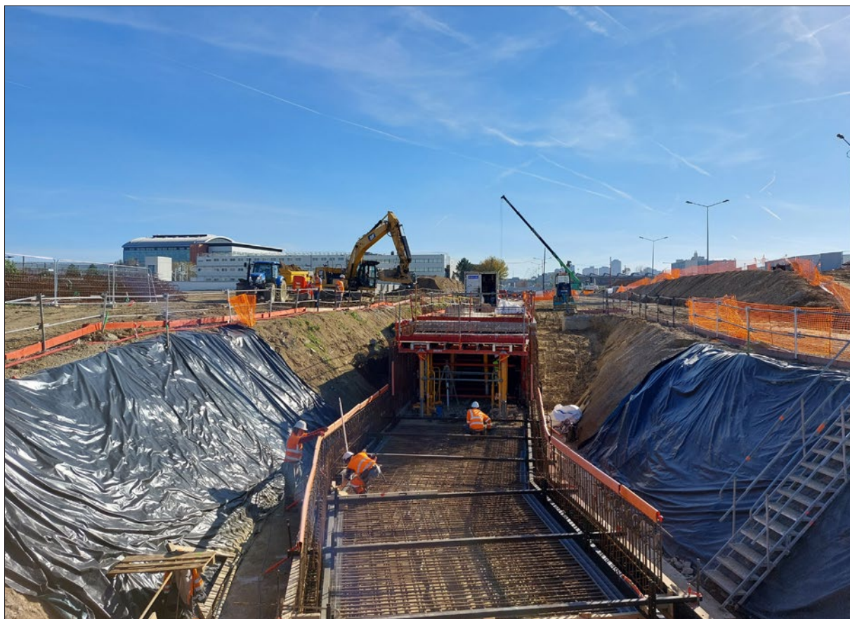
Figure 276 : Mise en œuvre cadre hydraulique, ZAC Gare-Ardoines - Source : Benoît Yacine, Octobre 2021.
