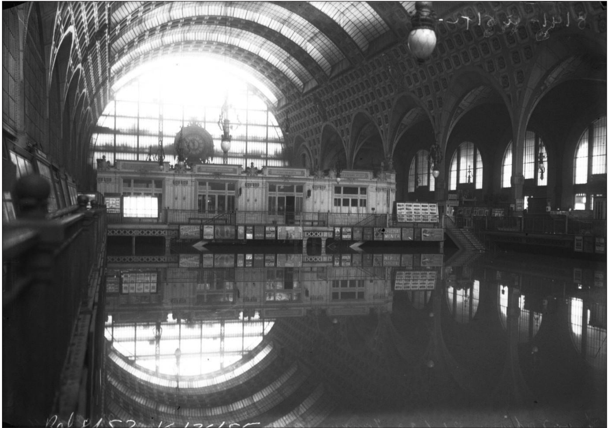
Figure 202 : Inondations, 21/30 janvier 1910, gare quai d'Orsay, Paris 7e arrondissement, intérieur inondé de la gare d'Orsay, Agence Rol 1910 - Source : gallica.bnf.fr /Bibliothèque Nationale de France.
