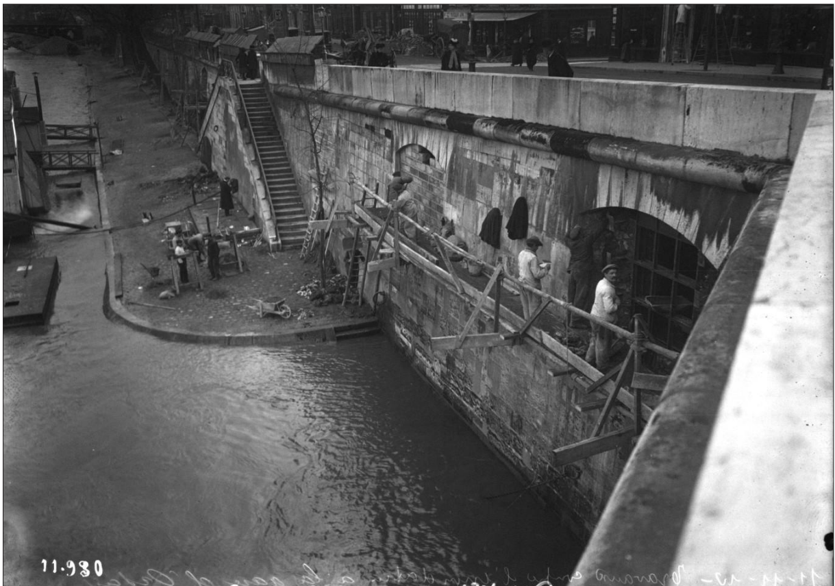
Figure 203 : 11 novembre 1910, travaux contre l'inondation à la gare d'Orsay, Agence Rol 1910 - Source : gallica.bnf.fr / Bibliothèque Nationale de France.
