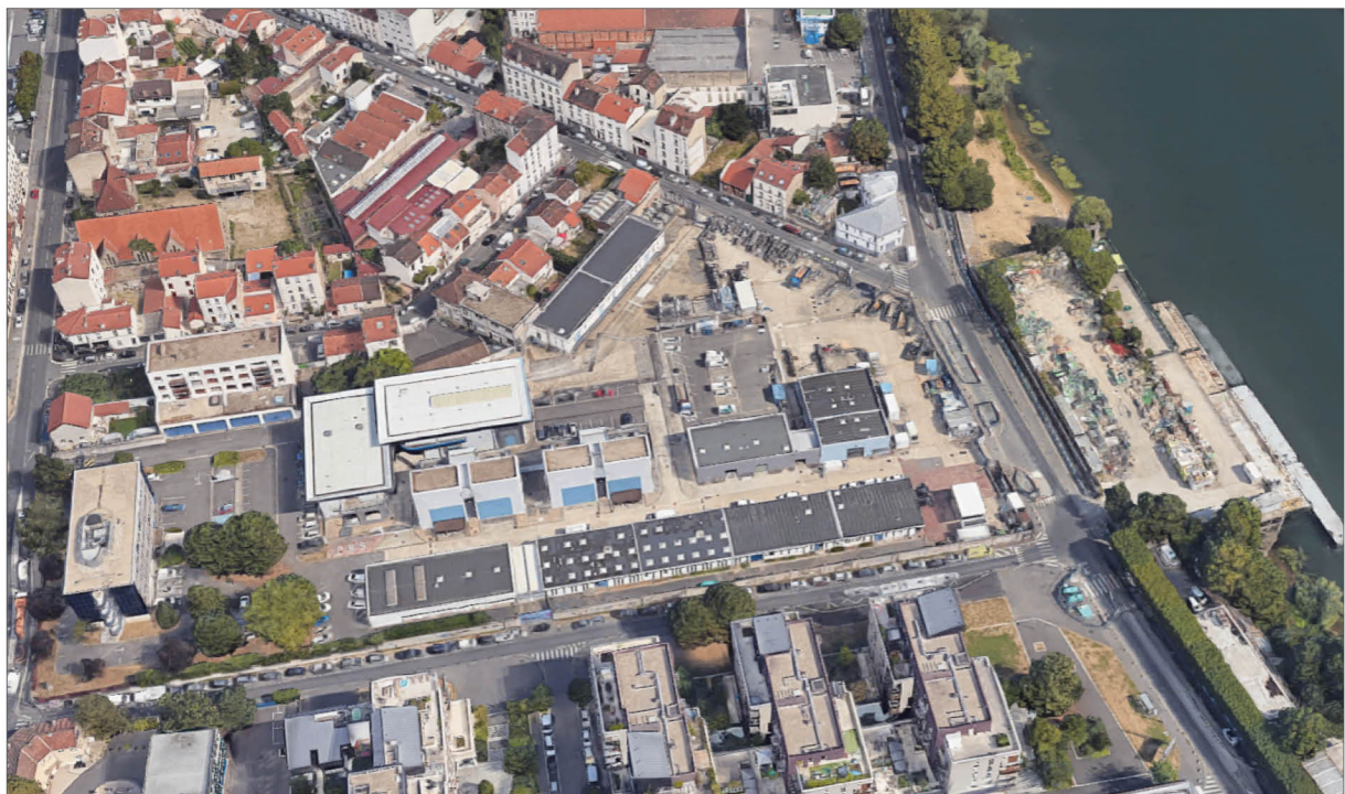
Figure 50 : Poste source Vitry-sur-Seine - Source : Google map, 2023.
