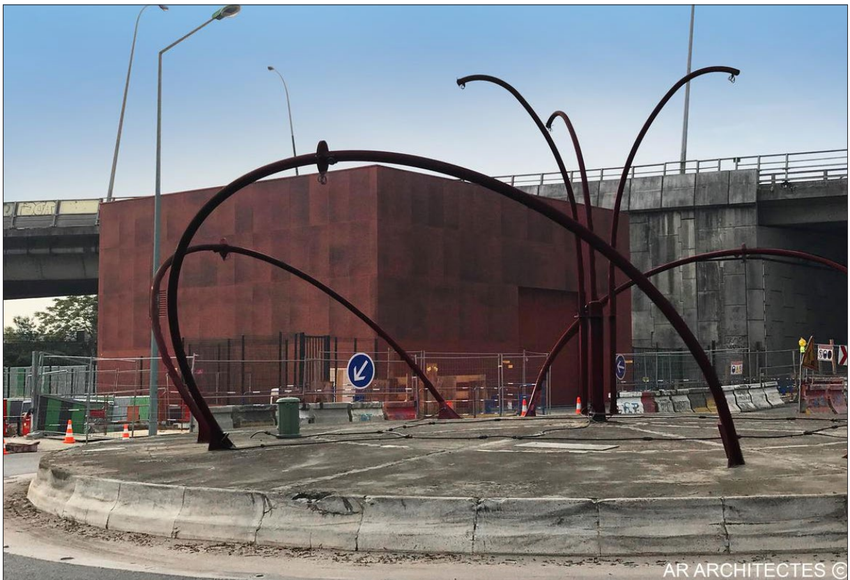
Figure 227 : Station de pompage anti-crues de Vitry-Sur-Seine, ZAC Gare-Ardoines - Source : © AR ARCHITECTES.
