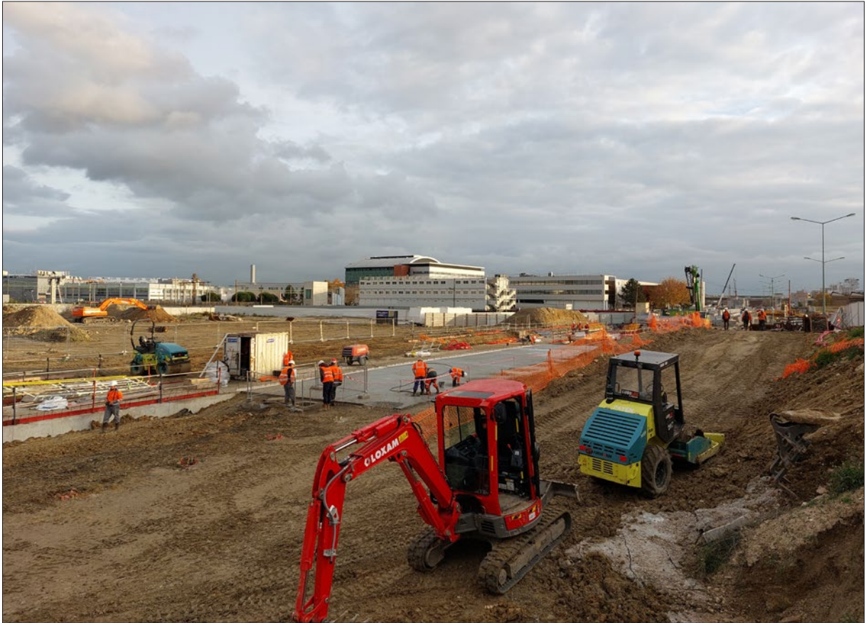
Figure 278 : Mise en œuvre cadre hydraulique, ZAC Gare-Ardoines - Source : Benoît Yacine, Novembre 2021.
