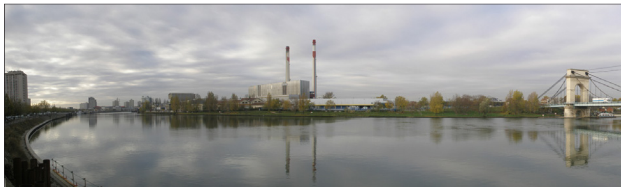
Figure 31 : Vue panoramique de la zone d'activités des Ardoines à partir d'Alfortville - Source : SEURA Architectes.
