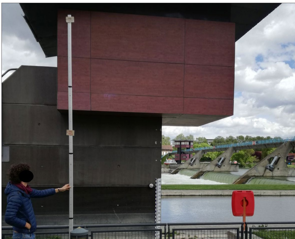
Figure 213 : Repère de crue 1910, Chemin de Halage - Cabine VNF, Vitry-sur-Seine - Source : DIREN IDF.
