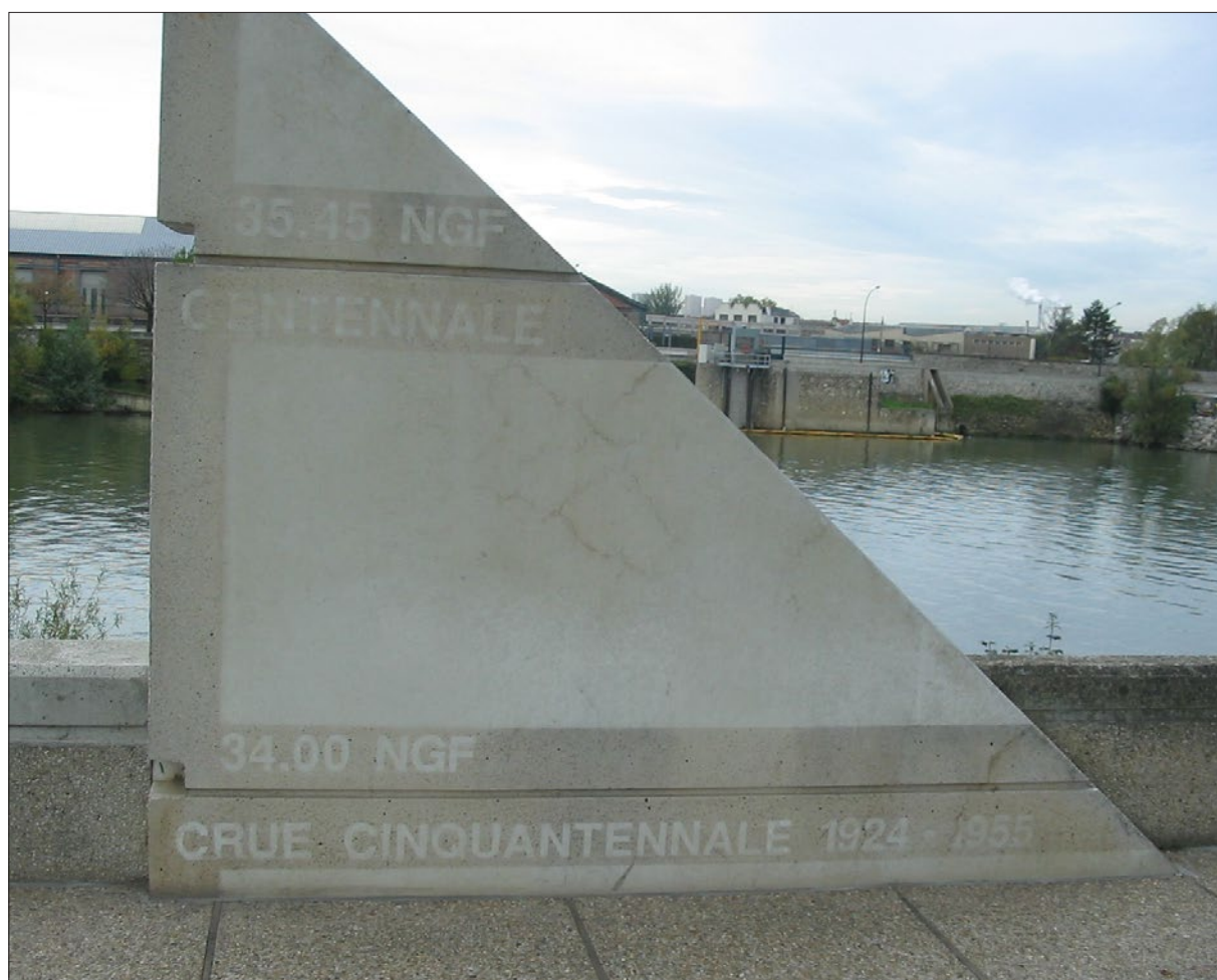
Figure 211 : Repère de crue 1924, quai Blanqui, Alfortville - Source : DIREN IDF, SPC SMYL.
