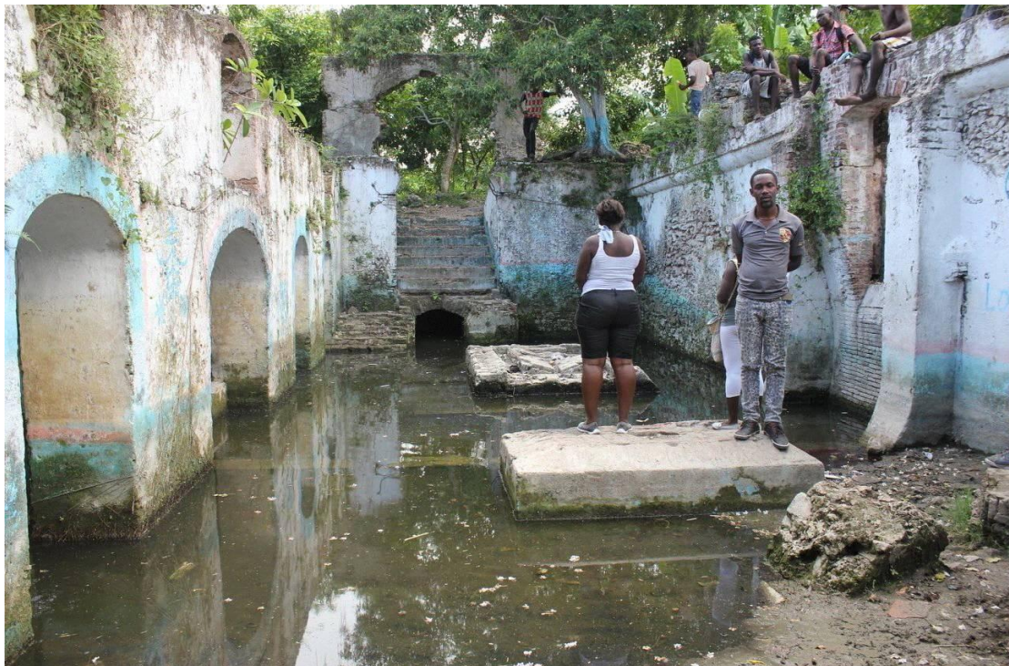
Image 15.- Photo du bassin Lovana à Quartier-Morin dans le Nord
