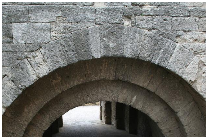
Figure 64. Détail, passage sous le chœur, Saint-Pierre (Montbazin).
