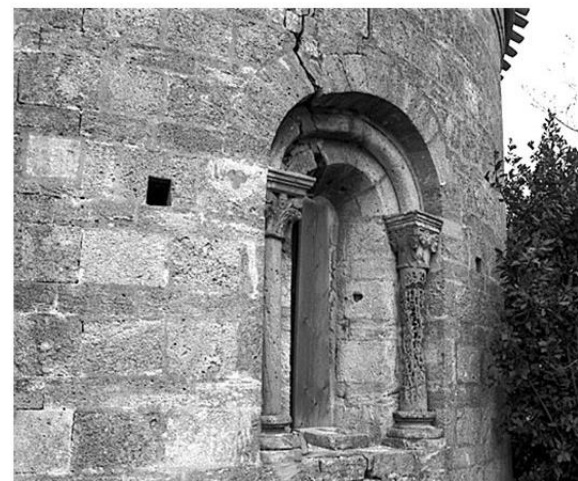
Saint-Michel (Montels), détail du chevet
