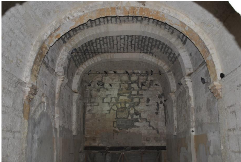
Figure 41. Couvrement de la nef, vu depuis l'est (2017).
