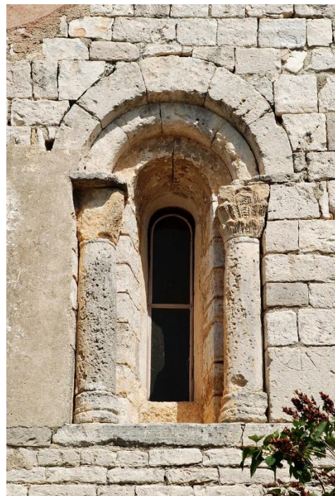
Figure 62. Baie méridionale, vue depuis l'extérieur (2017).
