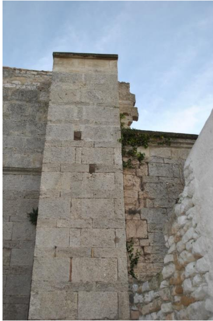
Figure 40. Contrefort, première travée, mur nord (2020).
