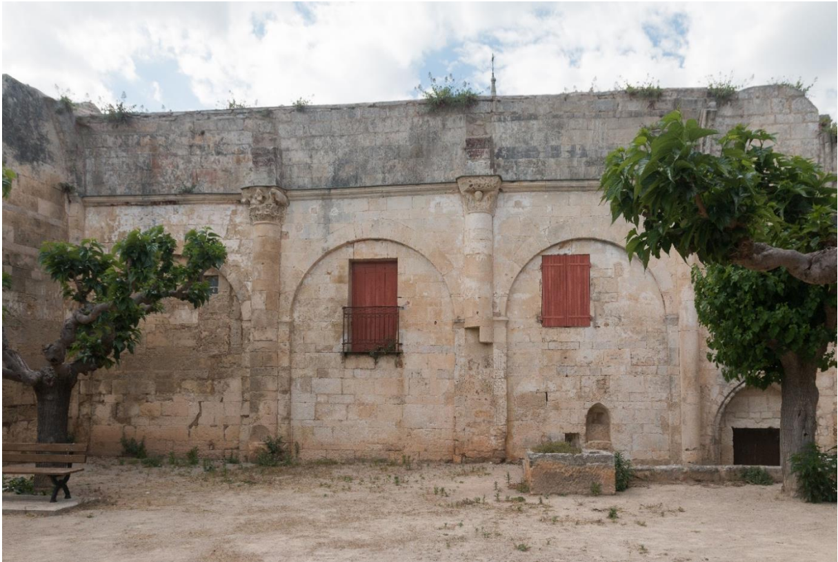
Figure 97. Parement intérieur du mur nord, Saint-Étienne (Castries).
