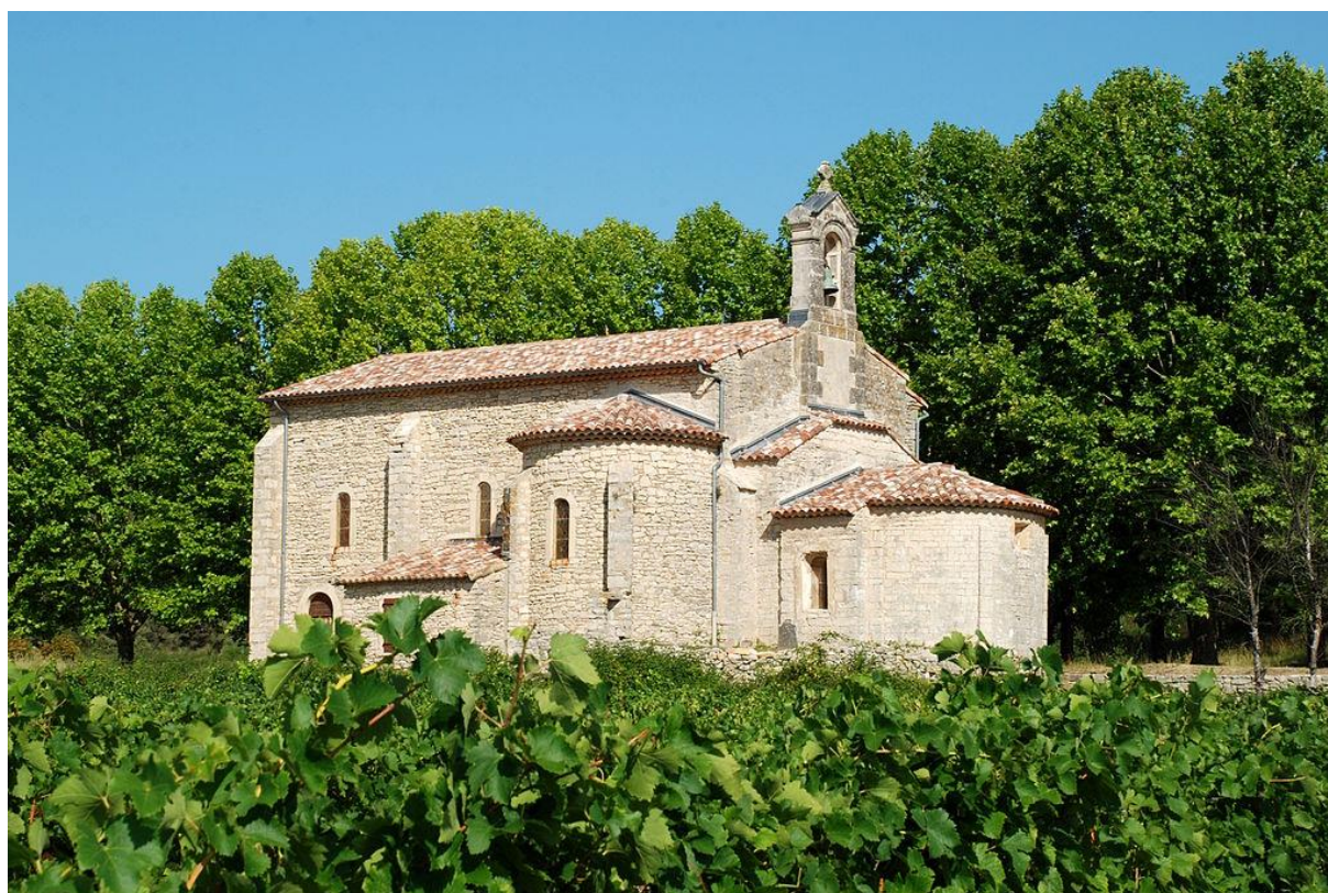
Figure 125. Façade sud et chevet (2022).
