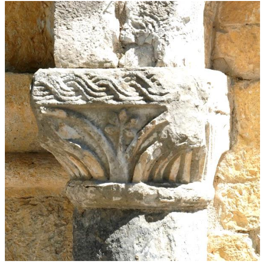
Figure 56. Détail du portail, chapiteau de droite (2019).
