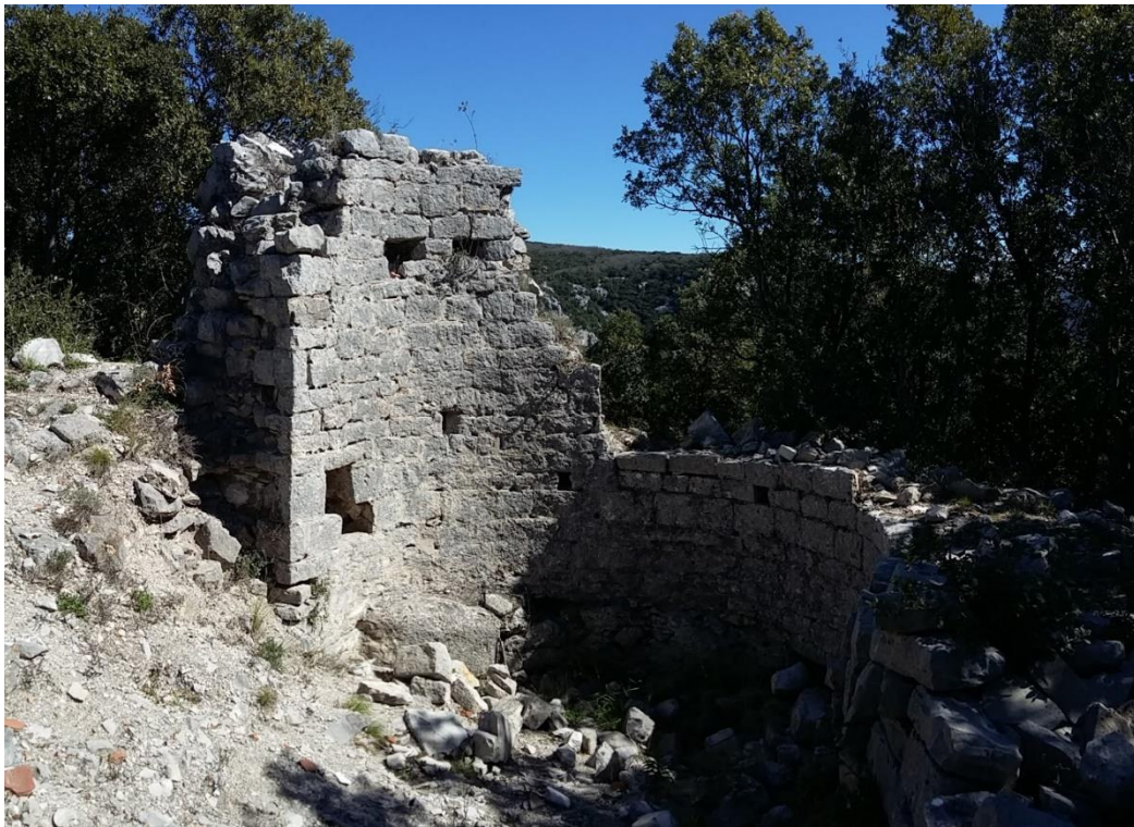
Figure 8. Vue de l'abside romane (2017).
