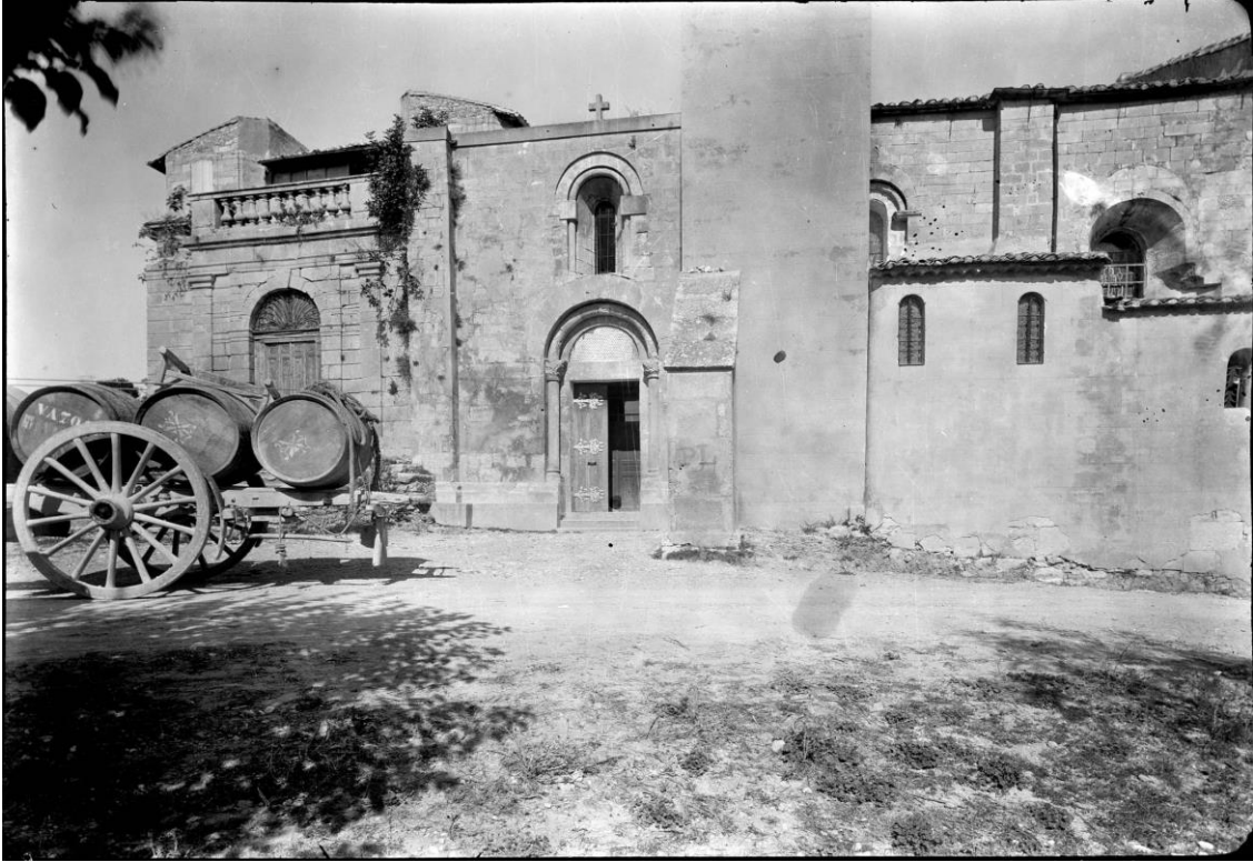
Figure 23. Photographie noir et blanc, façade sud, [s.d., XX e s. ?], dossier de protection.
