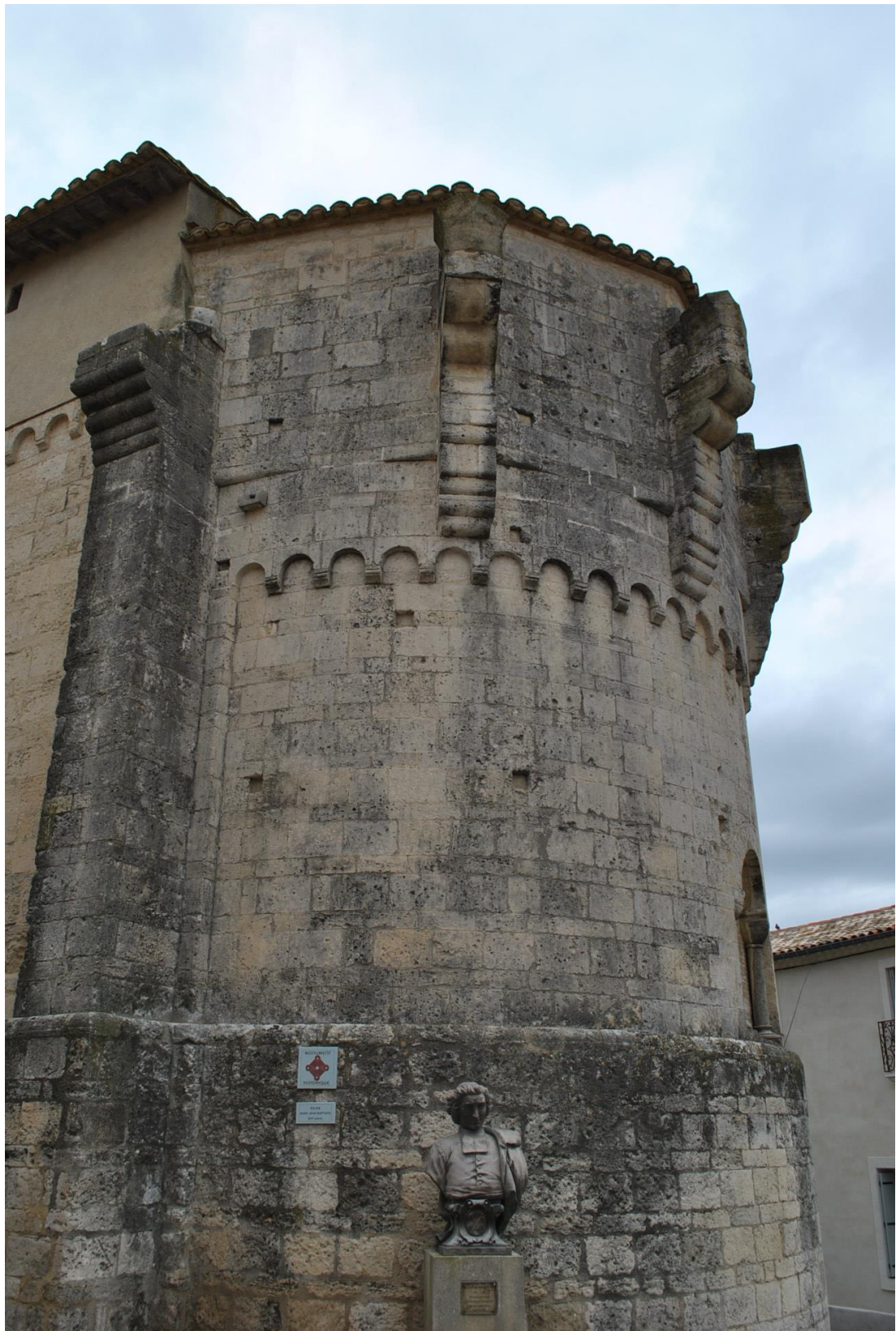
Figure 69. Chevet, vu depuis le sud (2023).
