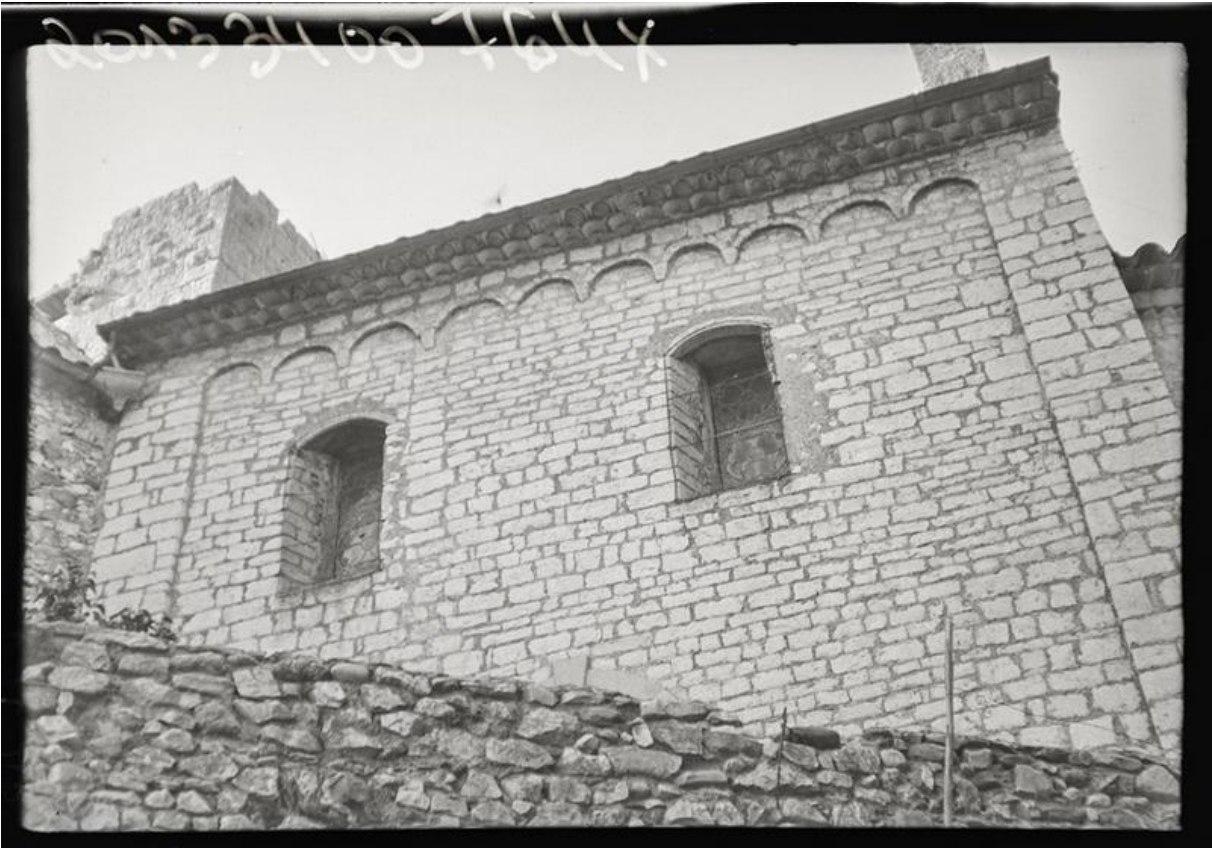
Figure 84. Façade sud (courant XX° s.).
