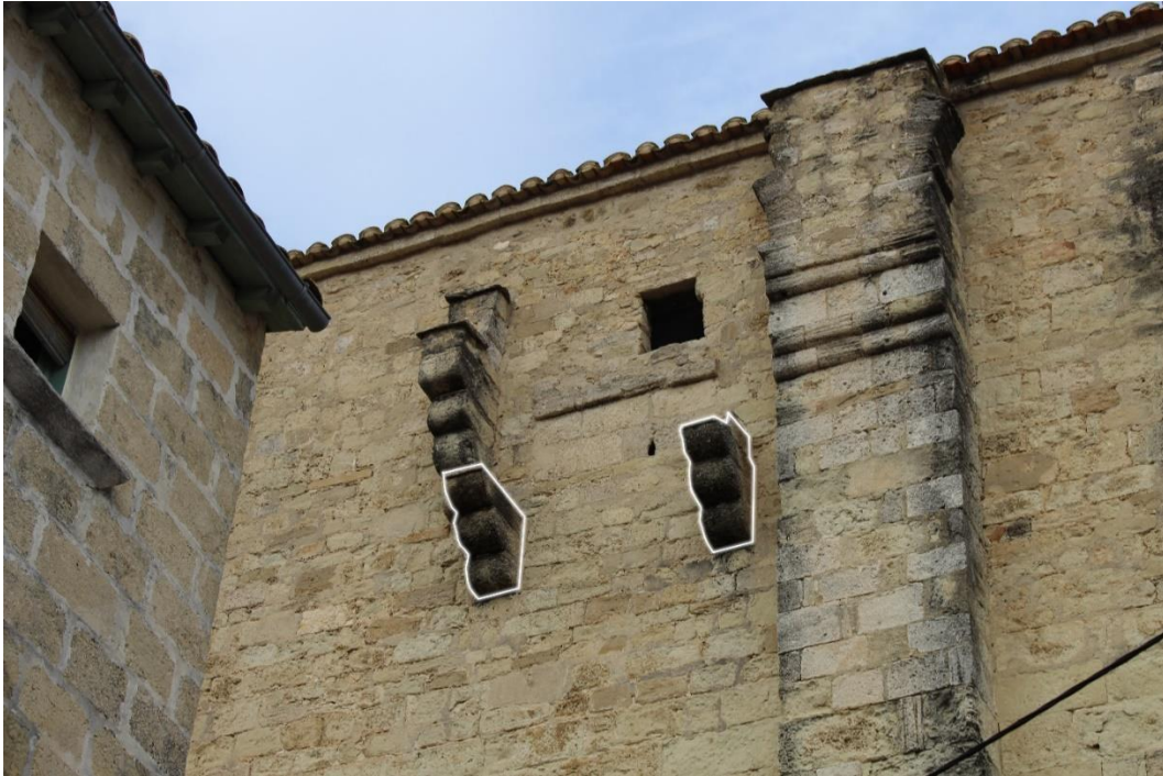
Figure 81. Mur méridional, deuxième travée, Sainte-Croix de Celleneuve (Montpellier). Mise en évidence des deux consoles conservées, correspondant probablement à l'emplacement d'une bretèche.
