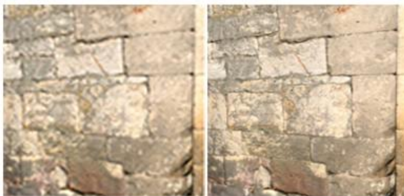
Figure 99. Comparaison des textures, niveau de détail à 50cm du mur, Saint-Sylvestre-des-Brousses (Puéchabon). Premier test avec un appareil photo (à gauche), quatrième test en drone (à droite).
