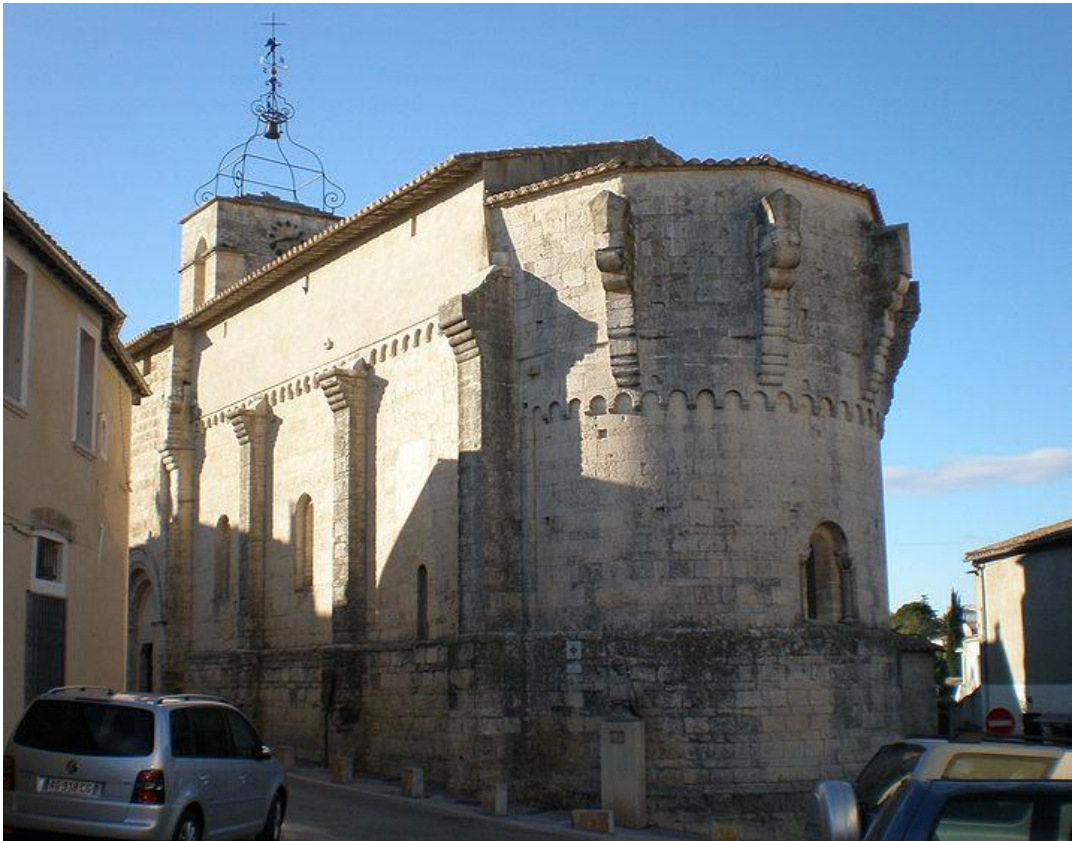
Figure 68. Façade sud et chevet (2023).
