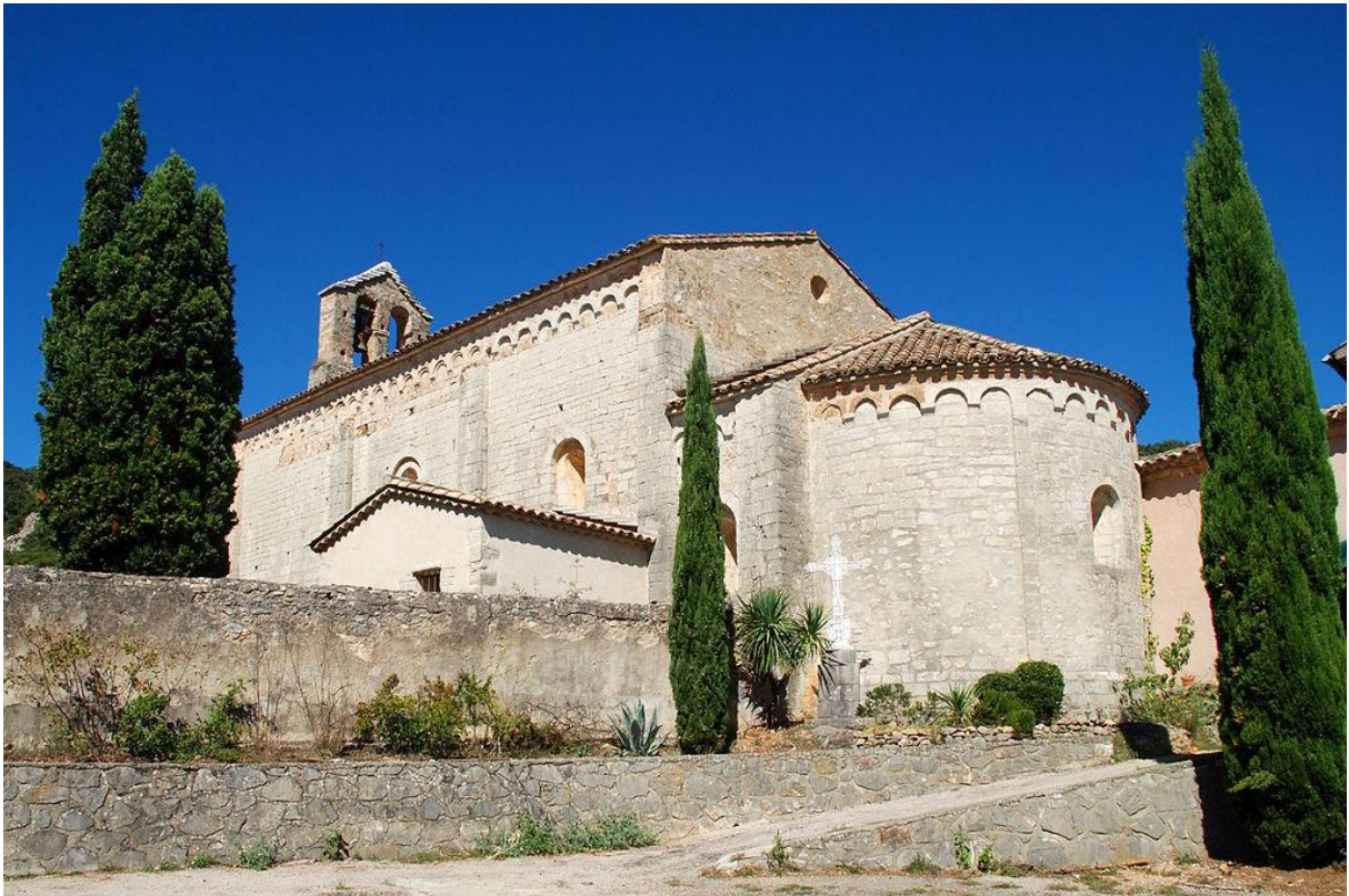
Figure 108. Chevet et façade sud (2019).
