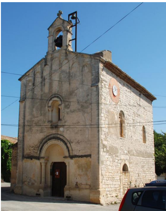
Figure 60. Façade ouest et mur sud (2017).
