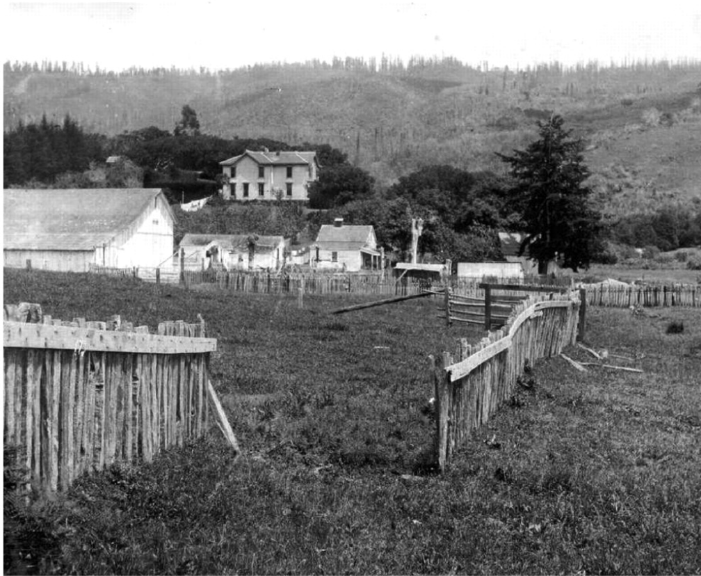
FIGURE 1.23 – Photographie des effets du tremblement de terre de 1906 à San Francisco, causé par la rupture d’une portion de la faille de San Andreas. La faille a glissé d’environ 2.5 m le long d’un plan de fissure particulièrement bien défini [74].
