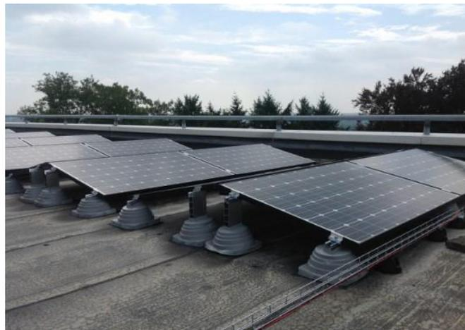
Figure 17 : Principe de fixation des modules photovoltaïques – 1/2
