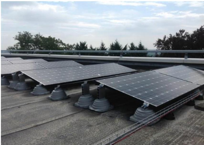
Figure 53 : Photo des modules photovoltaïques posé sur plots thermosoudés
