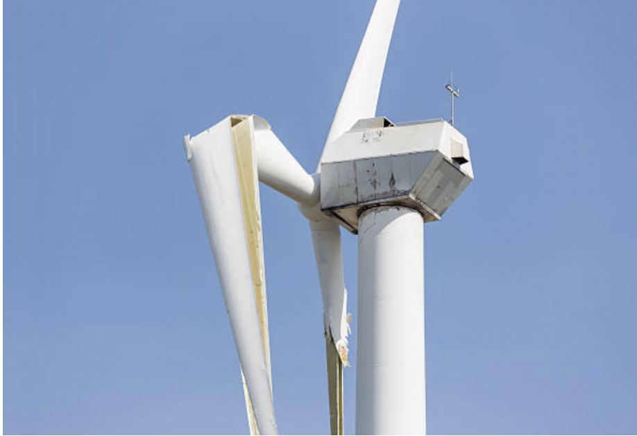
FIGURE 1.3 – Éolienne dont les pales ont subi un endommagement provoquant la ruine complète de la structure.
