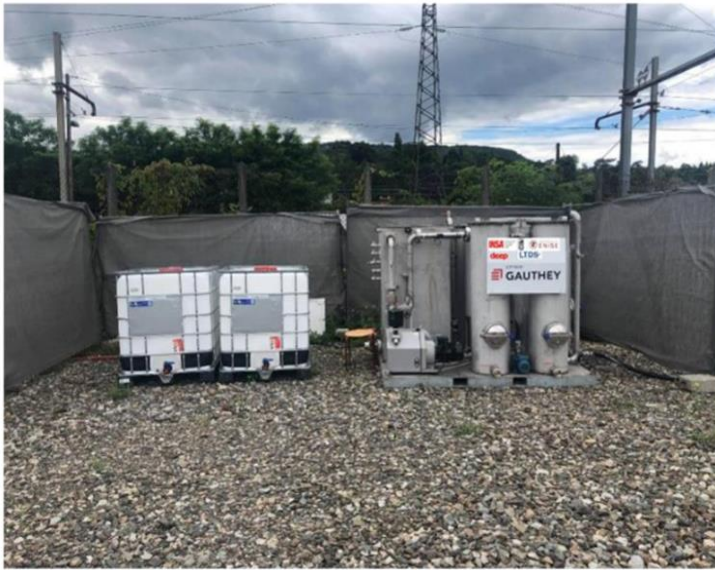
a- Le système d'extraction SVE
