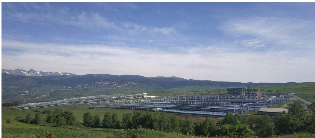
Figure I.30 : Photo de la centrale solaire eLLO à Llo dans les Pyrénées-Orientales
