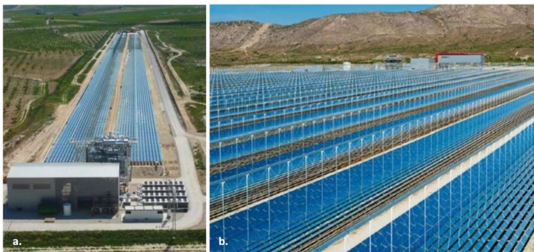
Figure I.24 : (a.) Centrale solaire à concentration linéaire Fresnel Puerto Errado 1 ; (b.) Centrale solaire à concentration linéaire Fresnel Puerto Errado 2 [31]
