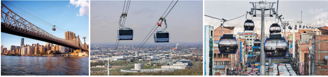
FIGURE 2: Téléphérique Roosevelt Island à New-York, USA (POMA), Téléo à Toulouse, France (POMA) et réseau de télécabine Mi Teleférico à La Paz, Bolivie (Doppelmayr Group)
