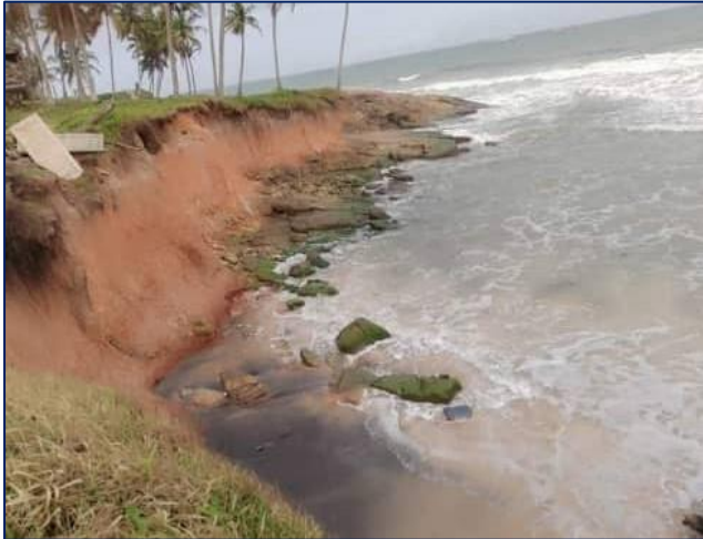
Photo 49 : Erosion à 200m du port de San--Pédro
