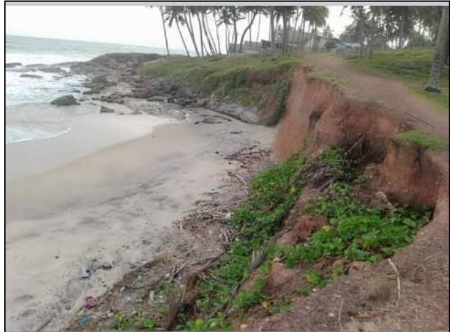
Photo 50 : Erosion à Balmer
