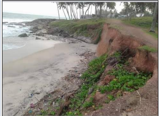
Photo 50 : Erosion à Balmer
