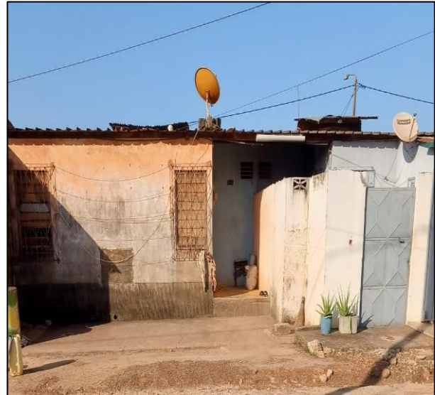
Photo 10 : Logement SOGEPHIA à San-Pédro
