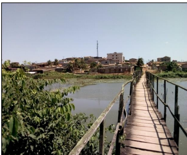
Photo 13 : Pont à péage reliant deux quartiers à San-Pédro
