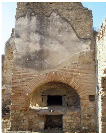
Figure 325. Four de la boulangerie V 4, 01-02 à Pompéi (d'après Monteix 2009, fig. 74).
