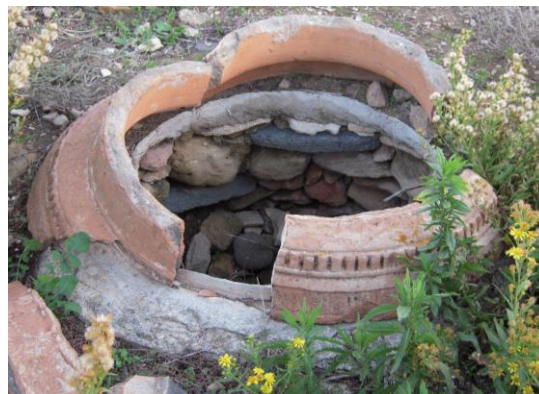
Figure 352. Puits dont la margelle et le parement sont construits avec des matériaux de récupération, notamment des meules, à Mégara Hyblaea.
