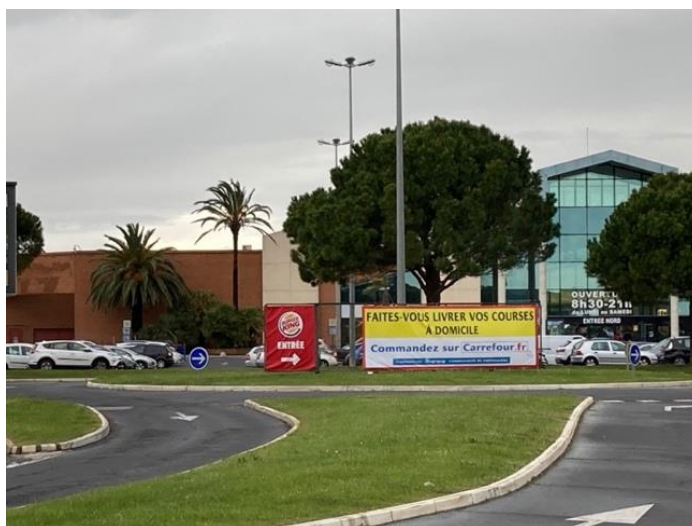
[Le centre commercial Bonne Source, dans la zone d'activités éponyme, à l'entrée de la ville de Narbonne. Photographie personnelle, 2022]
