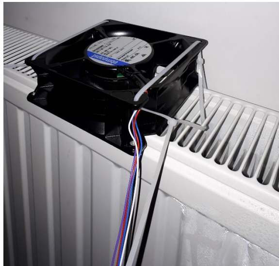
Figure 5-21 - Exemple disposition d'un ventilateur axial simple
