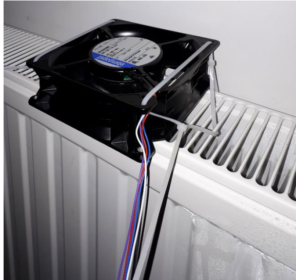
Figure 5-21 - Exemple disposition d'un ventilateur axial simple
