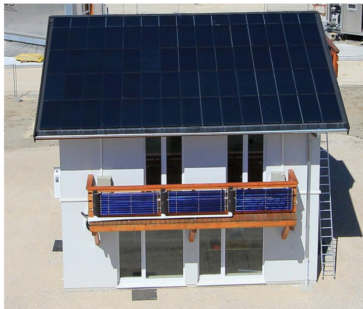
Figure 2-1 : Photo de la maison I-BB
