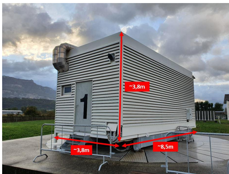
Figure 5-13 : Vue extérieure d'une cellule Passys
