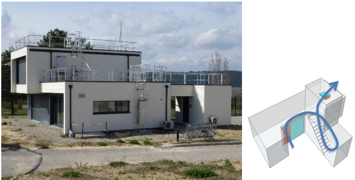
Figure 4-1 : A gauche, photo de la maison expérimentale, à droite volume d'air naturellement ventilé dans l'étude
