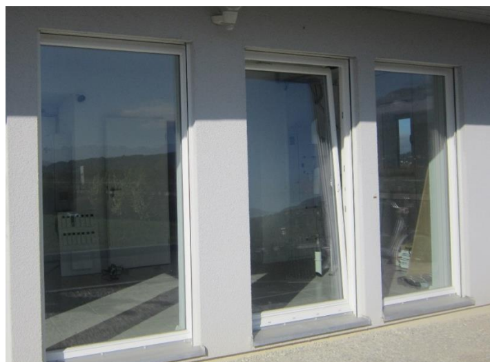
Figure 3-3: Fenêtre Oscillo-battante de la maison Ossature-bois (L-B), RDC paroi sud
