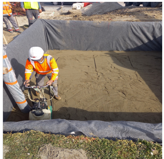
FIGURE 2.12 – Remplissage et compactage d'une couche du stockage
