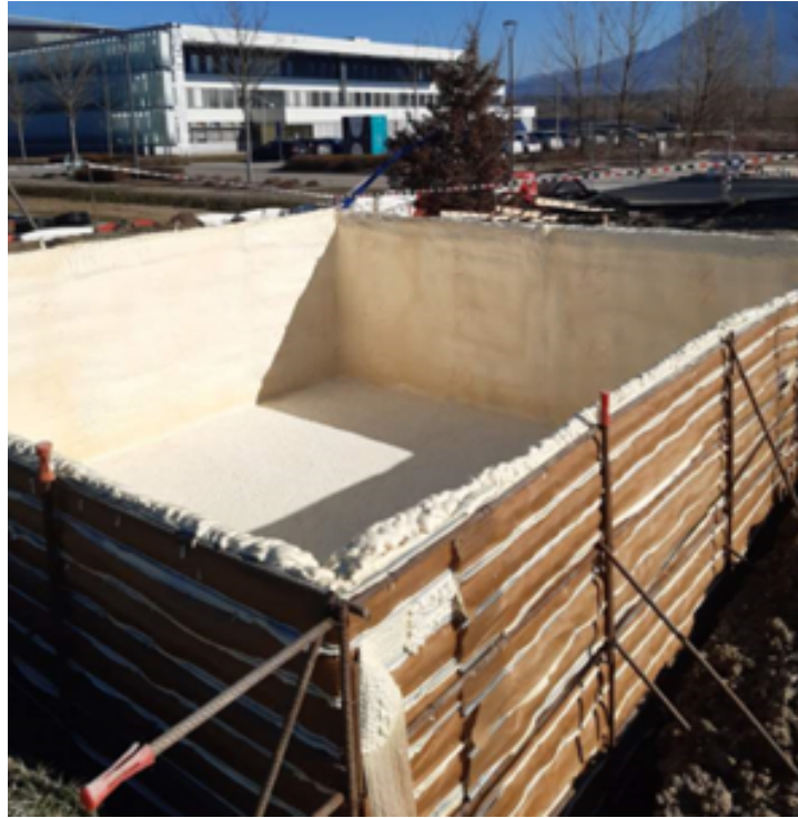
FIGURE 2.11 – Coffrage métallique avec isolation du stockage
