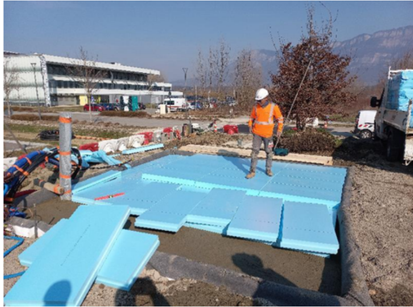
FIGURE 2.14 – Isolation du toit du stockage thermique
