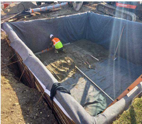
FIGURE 2.12 – Remplissage et compactage d'une couche du stockage
