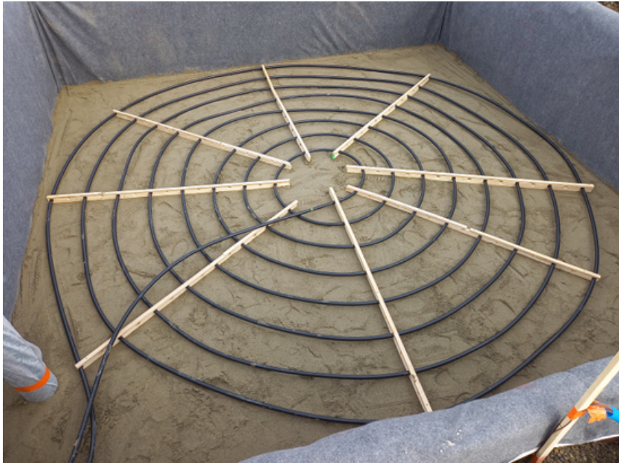
FIGURE 2.13 – Tube géothermiques en forme de spirale dans le stockage
