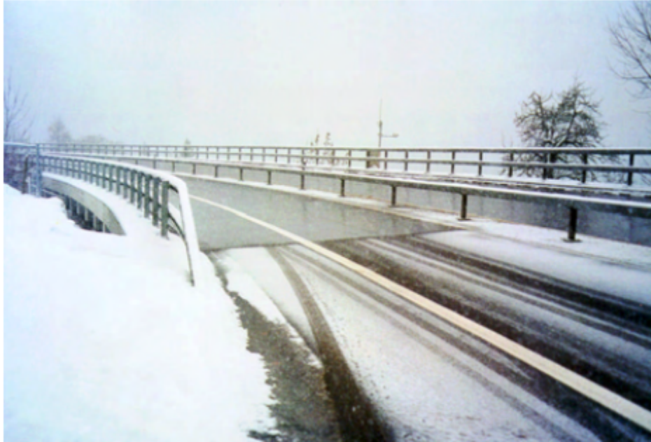
FIGURE 1.8 – Pont SERSO en fonctionnement [25]
