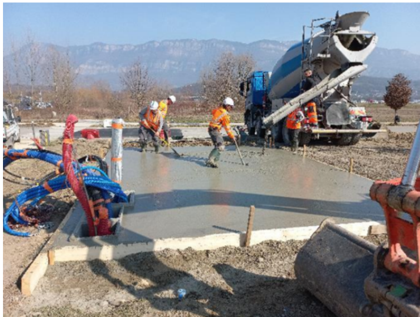
FIGURE 2.15 – Dalle en béton de du stockage thermique
