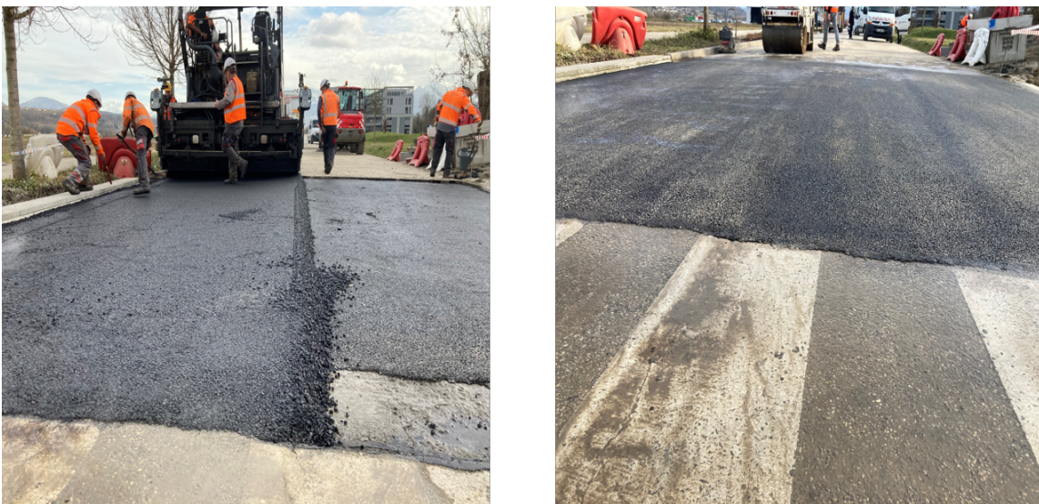
FIGURE 2.9 – La pose de l'enrobé de surface
