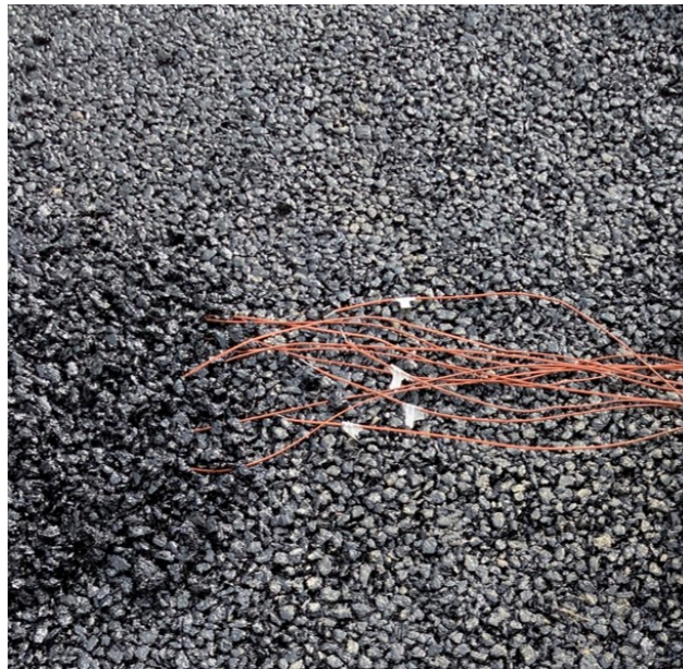
FIGURE 2.20 – Thermocouples type T posés dans la chaussée
