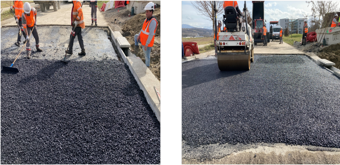
FIGURE 2.8 – La pose de l'enrobé drainant
