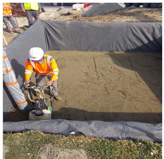
FIGURE 2.12 – Remplissage et compactage d'une couche du stockage
