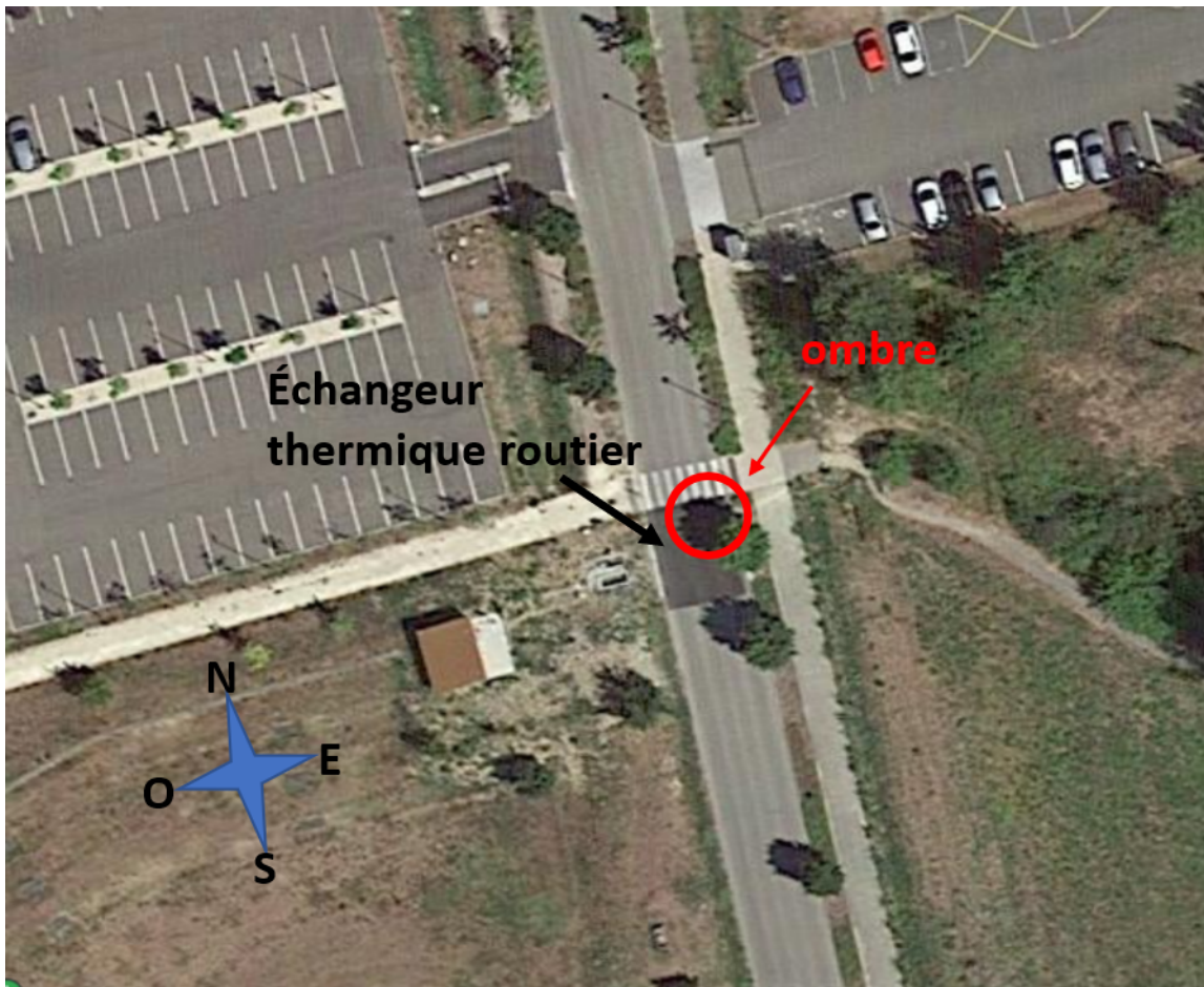
FIGURE 2.26 – L'échangeur thermique routier Dromotherm installé (vue aérienne)
