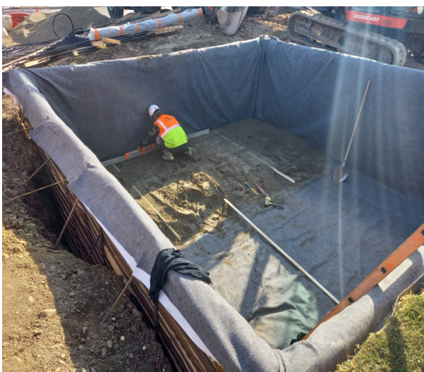
FIGURE 2.12 – Remplissage et compactage d'une couche du stockage
