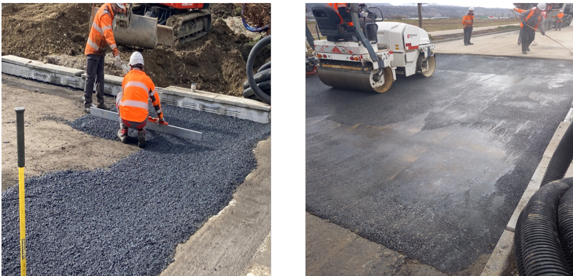
FIGURE 2.7 – La pose de l'enrobé étanche
