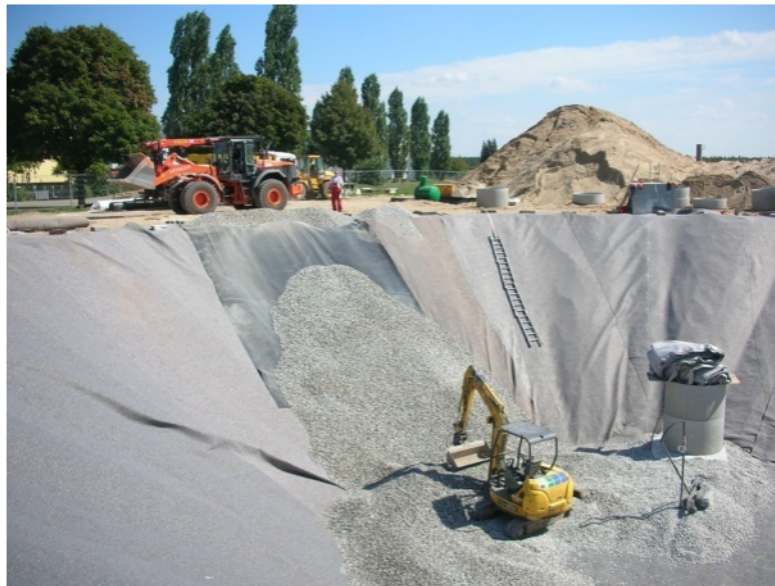
FIGURE 1.29 – Remplissage du PTES de Eggenstein-Leopoldshafen[40].
