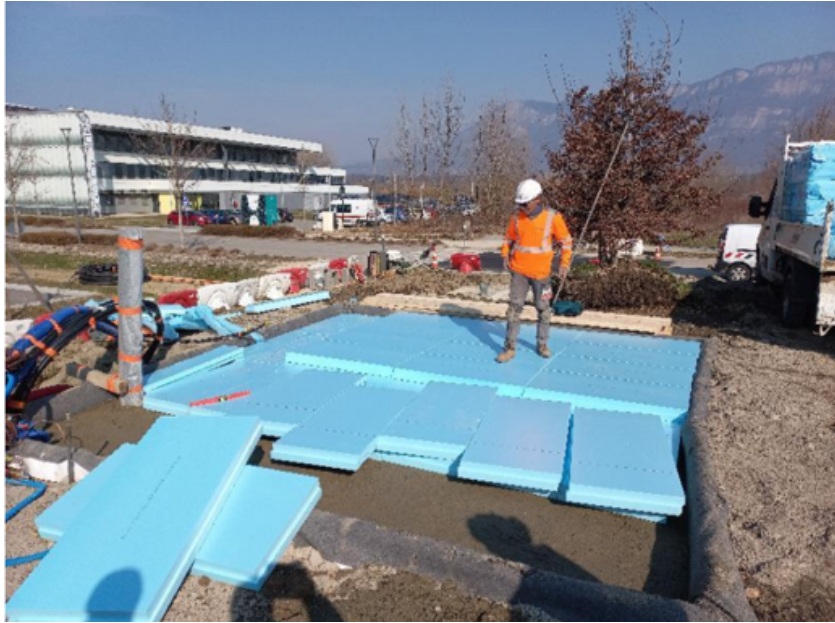
FIGURE 2.14 – Isolation du toit du stockage thermique
