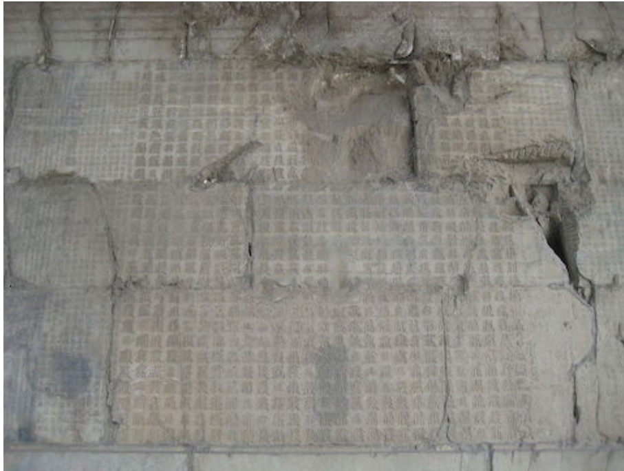
FIG. 1.6 : Paroi intérieure du mur de la passe de Juyong
