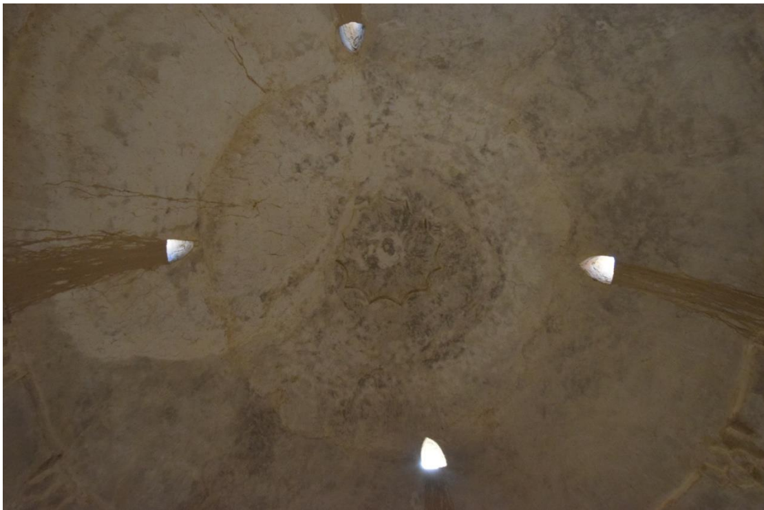
Figure 11 Toit de la mosquée
