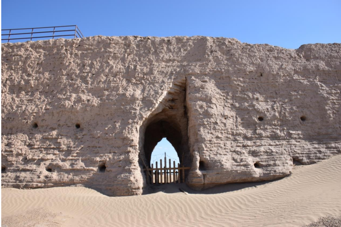
Figure 7 Trou par lequel le général Hei s'est échappé
