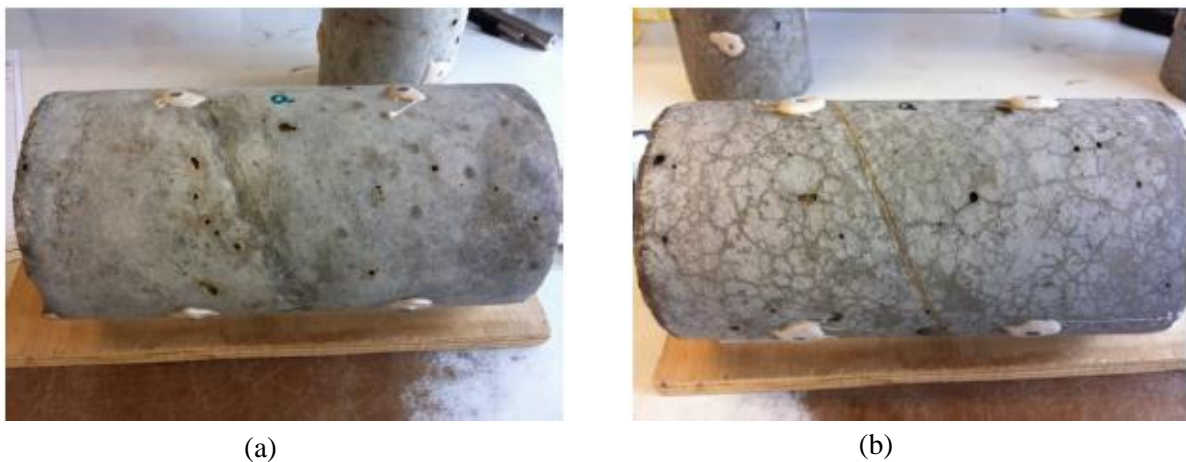
Figure I.21 Éprouvettes cylindriques de béton (diam. : 11 cm, long. : 22 cm) : (a) béton sain ; (b) béton atteint de RSI [158].
