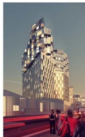
Projet connexe à la gare du GPE, Créteil, France
