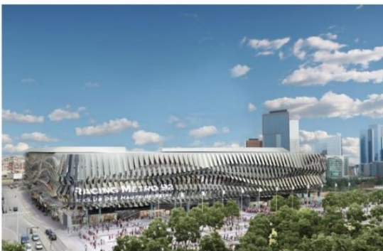
Stade Arena 92, Nanterre, France
