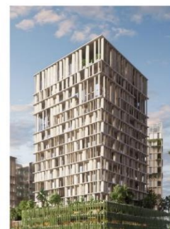
Complexe Akwaba, Abidjan, Côte d'Ivoire
