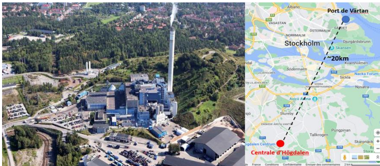
Figure 53: à gauche, vue aérienne de la centrale d'Högdalen et à droite, distance entre le port et la centrale (photo : Stockholm Exergi)
