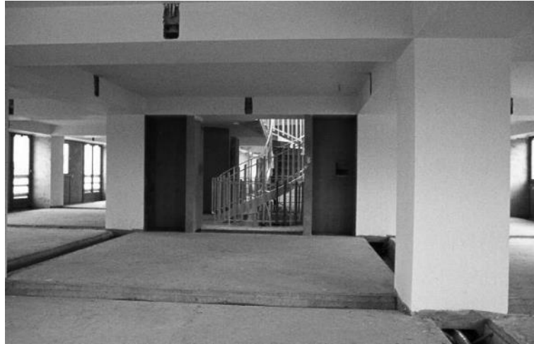
Figure 3-. Les Marelles: Photographie du plateau brut à la fin de la phase 1 avant l'aménagement intérieur choisi par les futurs habitants (DAF, CAPA, archives Maurios).
