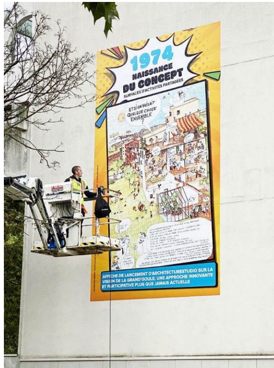
Figure 6- : Affiche posée sur la façade des bâtiments dans le cadre de la phase 1
