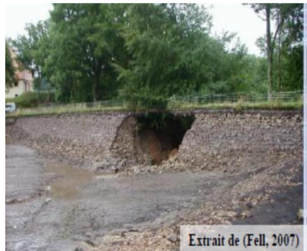
*Figure 1.2 : Impact de l'érosion sur des ouvrages : a-) sur une digue à Novato, Californie, 2005, b-) sur le barrage des Ouches (extrait de Fell, 2007)*
