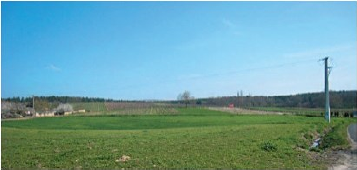
Figure 1.6 Affaissement à l’aplomb d’une carrière souterraine à Meigné (49) (Bérenger et al. 2014)
