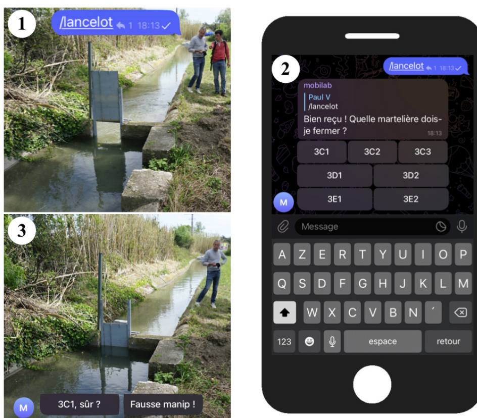
FIGURE 3.3 – Expérimentation de l'automatisation des vannes d'irrigation gravitaire par le système Lancelot : pilotage au smartphone par l'utilisateur.
