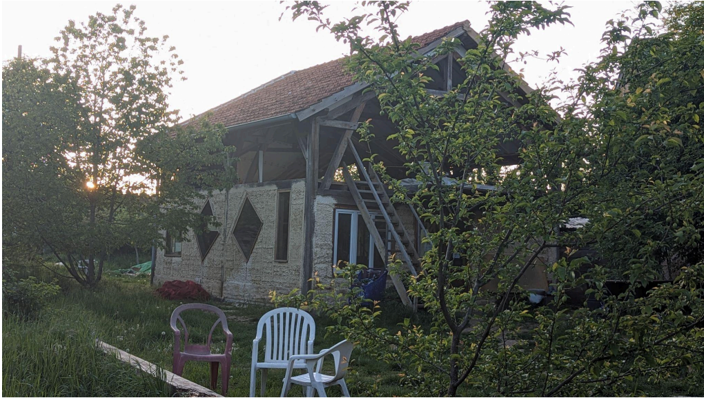
La Maison commune, chantier commun en cours
