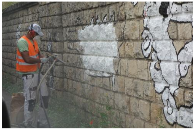
Effacement des fresques par le technicien équipé de la ville
