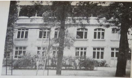
Le nouveau bâtiment
