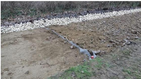
Annexe 11: site A-SBA lors de la phase travaux. (a) Raboteuse retirant et concassant l'enrobé hydrocarboné de surface (le 15/11/2021), collecté dans un camion-benne. L'épaisseur du revêtement n'étant pas connu préalablement aux travaux, cette étape a été réalisé en deux fois (à 5 puis 10 cm), visible par les deux sillons. (b) Incorporation du DV au sol descellé de la parcelle MAX
