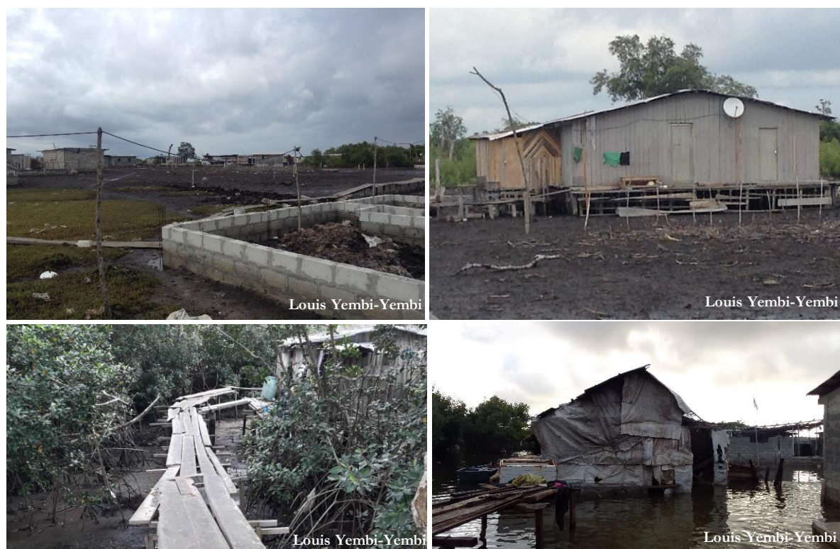
Figure 8-2 : Installation anarchique dans les zones de mangrove (zone quartier Lippe 2 et 3 au sud de la commune de Port-Gentil)
