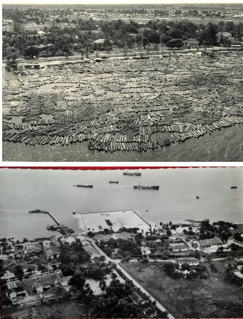
Figure 2-21 : Prise de vue oblique du parc à bois et de la construction du port Môle en béton dans la baie du Cap Lopez (source : https://www.delcampe.net/fr/collections/ )
