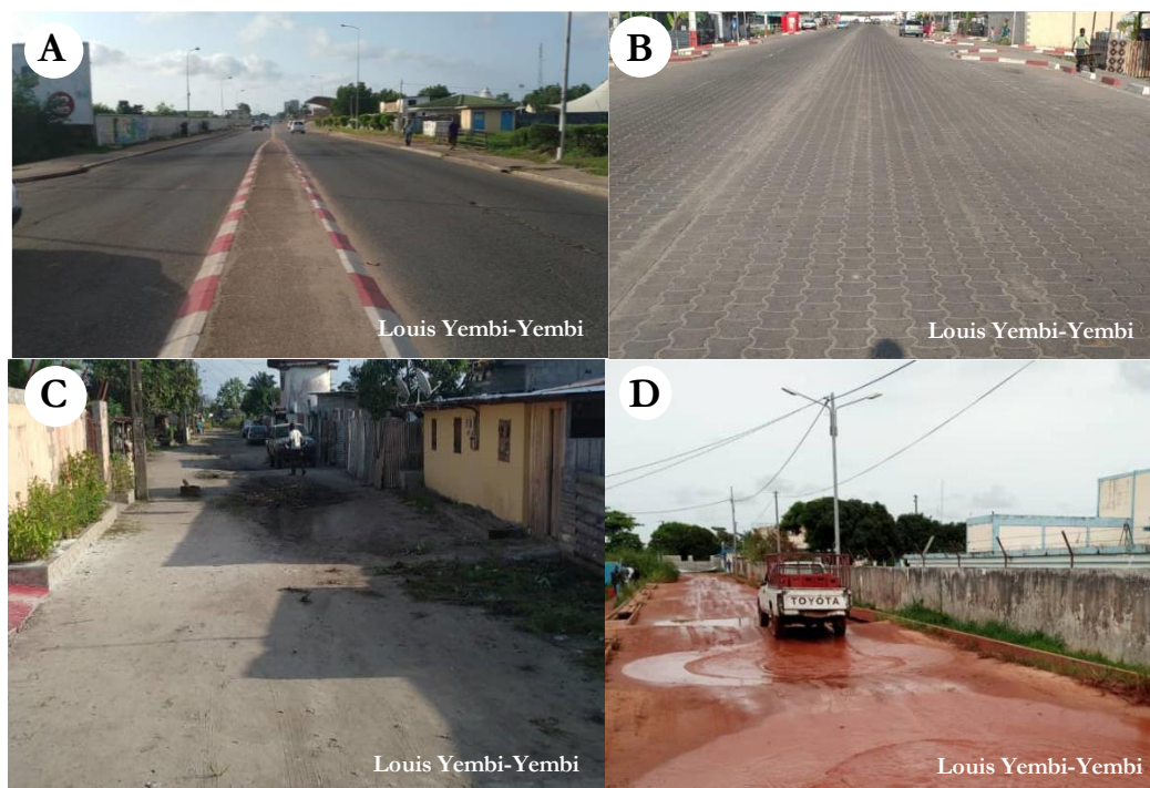
Figure 4-6 : Différents types de route avec et sans revêtement à Port-Gentil. Route bitumée du boulevard Léon MBA (Route principale) (A), Route pavée à la nouvelle route de Pentecôte (Route secondaire) (B), Route sans revêtement sur du sable derrière l'église Pentecôte (Route tertiaire) (C), Route en latérite dégradée par les inondations pluviales aux abords de la centrale de traitement de l'eau potable au quartier Bac-Aviation(D).
