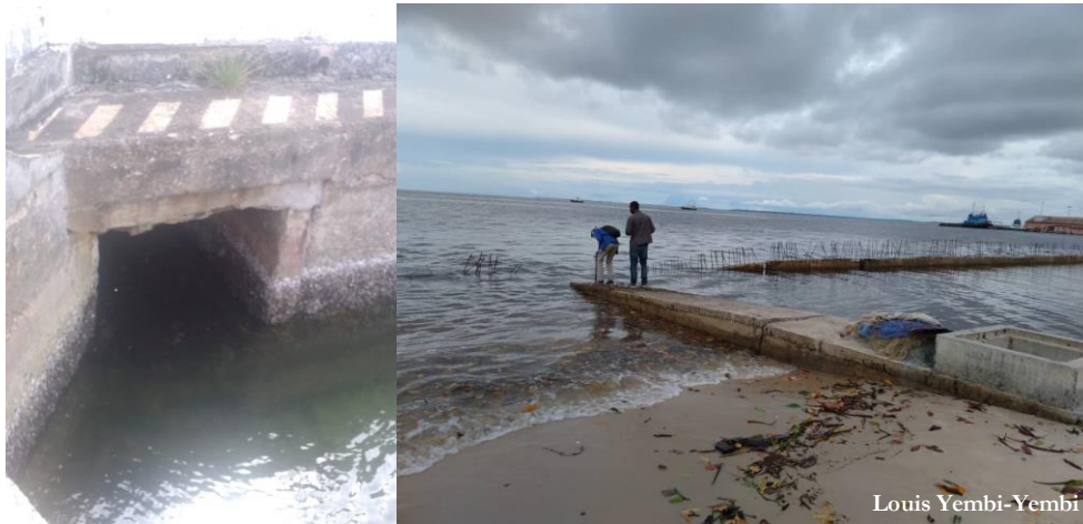
Figure 6-42 : Sortie des ouvrages d'assainissement des eaux de ruissellement vers la mer (Côte est).
