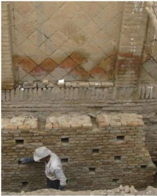
Fig. 47. De gauche à droite, Photo d'un canal anti-humidité (Fatemi,2017 :246), Canal anti-humidité du site de Nush-i Jān. (ICHTOH,1991)
