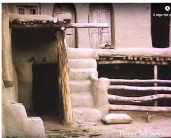
Fig. 25. Photo d'un escalier externe d'une maison en Iran. (Archive Penn museum, 1963)
