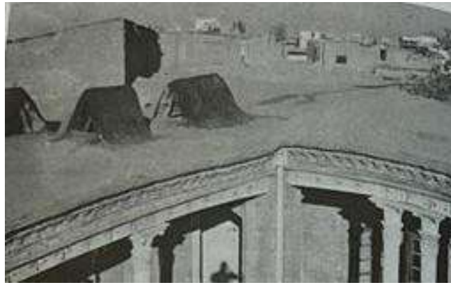
Fig. 4. Trous d'aération sur un toit plat. (Zamrashidi,2016 :149)
