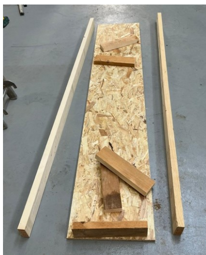
(a) Éléments nécessaires à la réalisation des lisses
