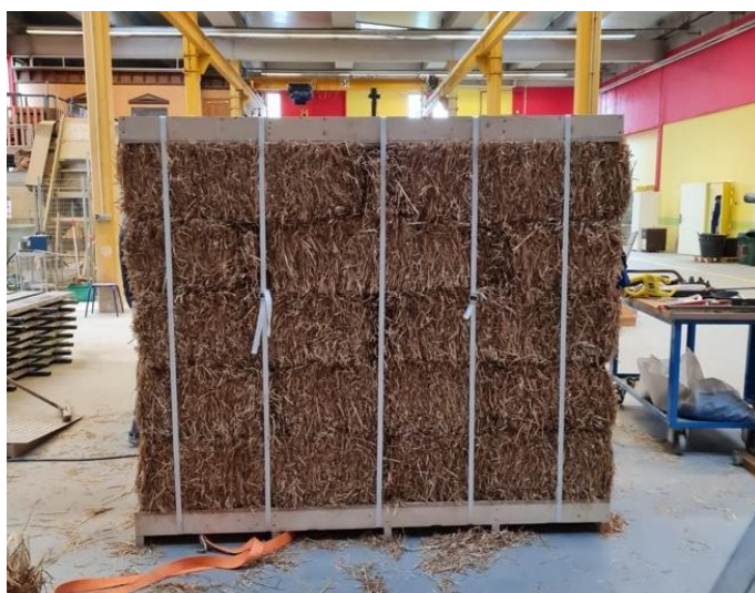
FIGURE 3.22. Précompression des murs avec sangles définitives
