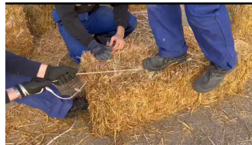
(b) Mise en tension de la ficelle jusqu'à obtenir la tension présente dans la ficelle d'origine
