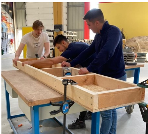
(b) Réalisation des lisses
