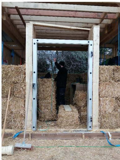
(a) Pré-cadres de menuiseries – Grenoble (2021)
