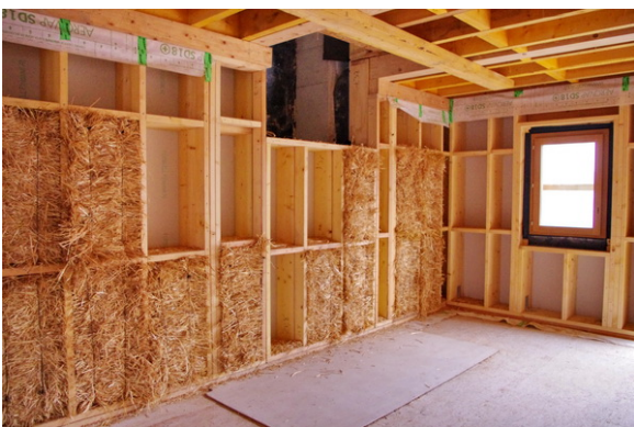
(a) Remplissage d'ossatures porteuses contreventées
