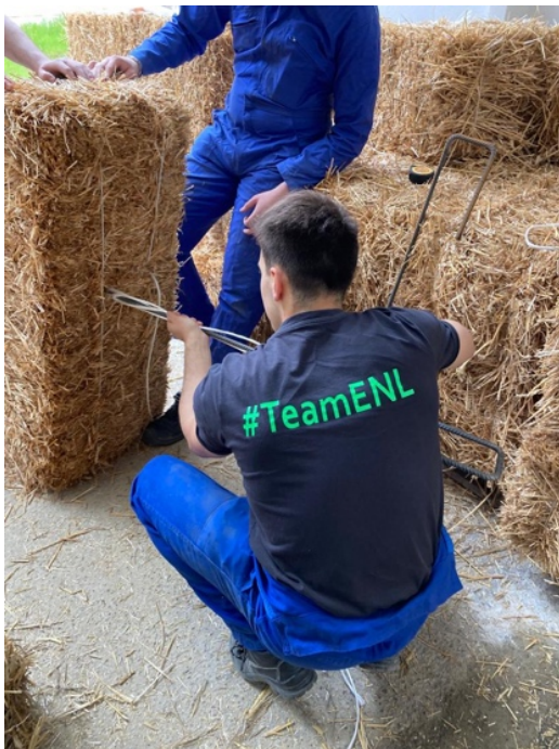
(a) Enfoncement des tiges de redimensionnement dans la botte
