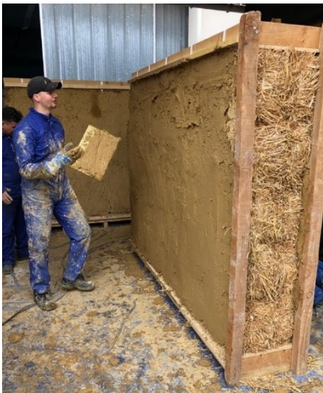
(c) Mise en œuvre du corps d'enduit
