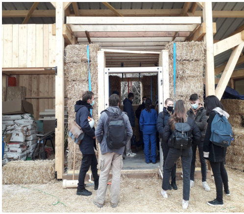
(a) Montage des murs avant précompression
