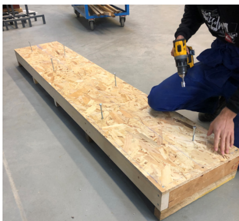
FIGURE 52. Mise en place des vis dans la lisse
