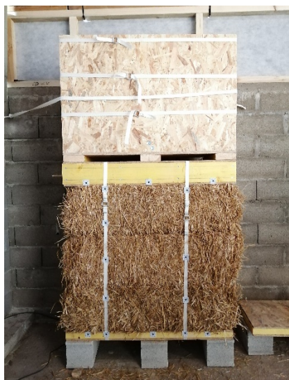
FIGURE 3.13. Chargement des murs avec une cuve remplie de granulats
