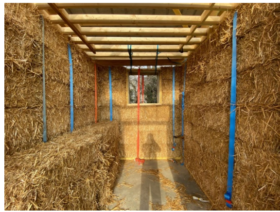
(b) Chambre froide après précompression et abaissement temporaire de charpente bois
