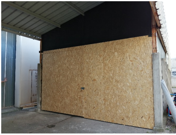
(a) Face avant du local
