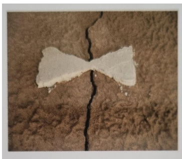
FIGURE 1.31. Pose d'un témoin au mortier de plâtre - (Source : RFCP (2023))
