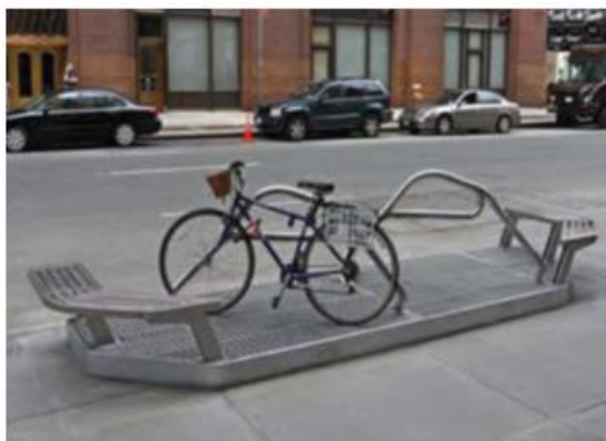
Figure III.E.10. Surélévation des grilles de ventilations dans le réseau de métro de New York.
