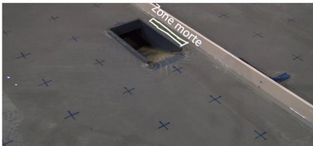
Figure 33. Injection de colorant et identification de la zone morte.
