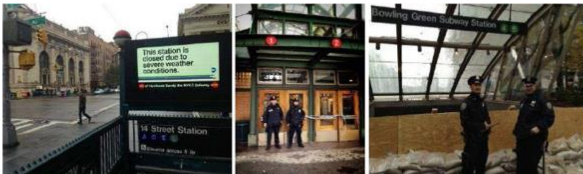
Figure 10. Sécurisation des accès du métro.
