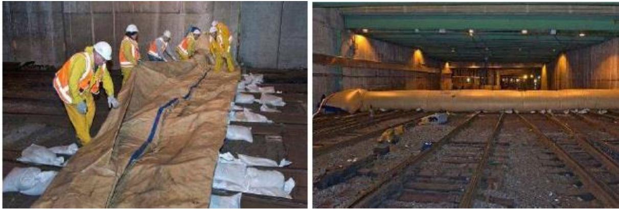
Figure 8. Mise en place de la protection gonflable.
