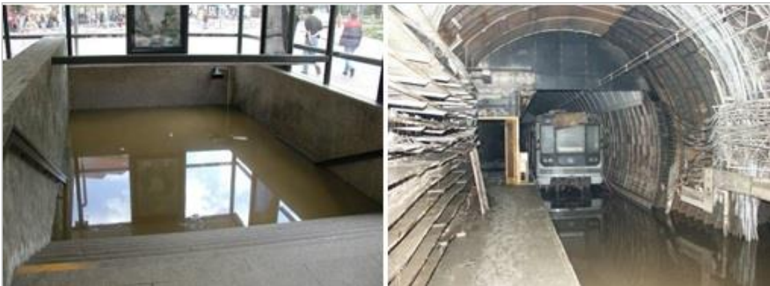
Figure 5. Station et rame de métro noyées (métro de Prague).
