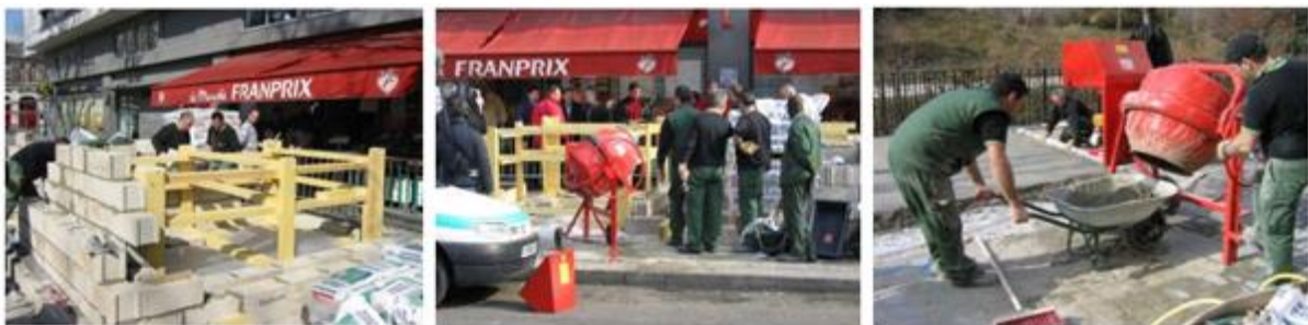
Figure III.E.5. Essai de montage de protection de protection sur une entrée d'eau.
