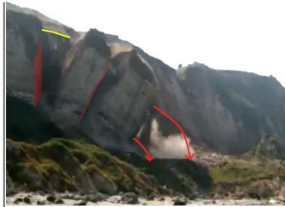
Basculement Saint Jouin Bruneval (Normandie, France) BRGM (2013)
