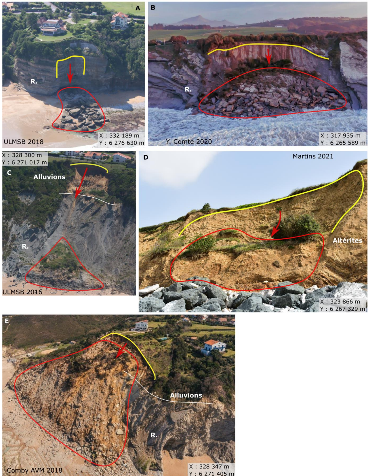
Figure 2.16 : Types d'instabilités gravitaires observés sur la côte basque. En jaune, l'escarpement sommital. En rouge, les matériaux mobilisés. La flèche représente le déplacement des matériaux depuis l'escarpement. Les matériaux sont distingués : rocheux (R.), alluvions et altérites. A : Chutes de blocs à la Pointe Saint Martin (Biarritz). B : Glissement rocheux banc sur banc à Urrugne. C : Glissement-coulée à Bidart. D : Glissement rotationnel de matériaux fins à Erromardie (Saint-Jean-de-Luz). E : Glissement de matériaux mixtes à Bidart.
