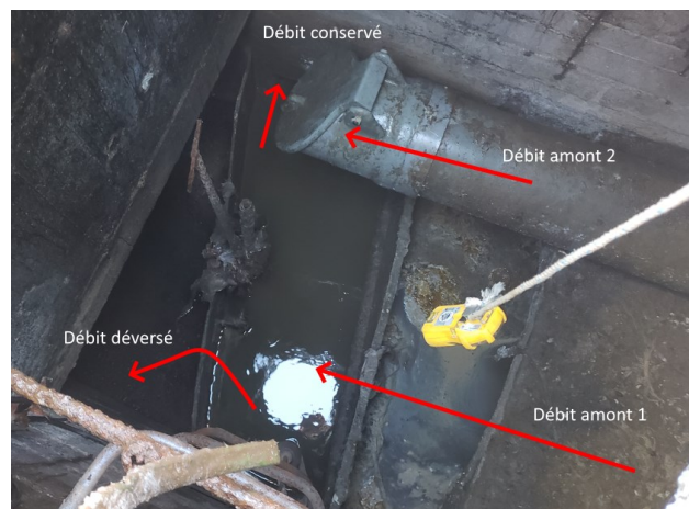
Figure 3.22: Déversoir d'orage « Pont du Gua »
