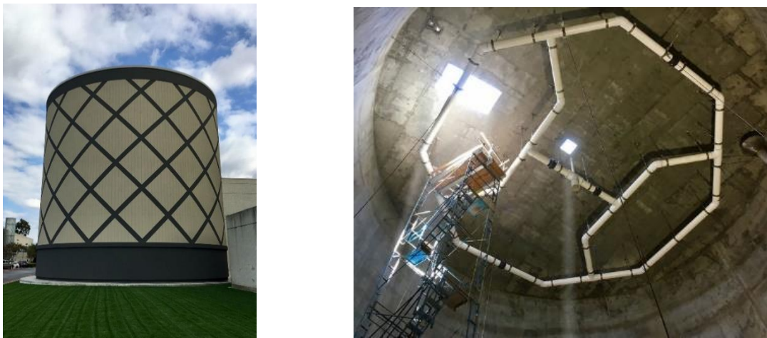
Figure 1-19 : Stockage (à gauche) et son système de distribution (à droite), implantés sur le campus de l'université de Cypress en Californie (issu de [21])
