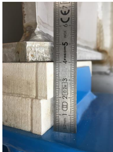
Figure 3-8 : Cales isolantes entre le stockage et son support
