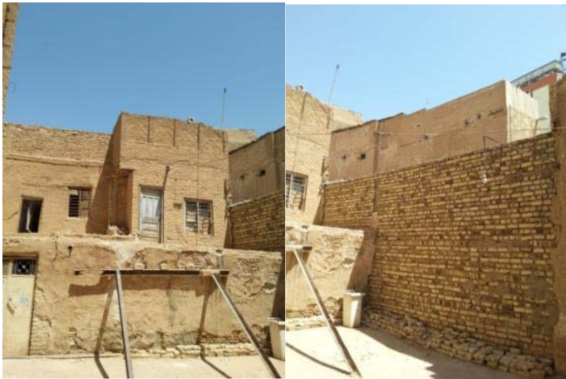
Figure 233 : Les vues extérieure de la maison de Sayyid Ibrāhīm Bahr al-'Ulūm (IAPN)
