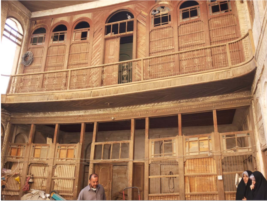
Figure 245 : La façade en bois de la deuxième maison d'al-Yāssarī (IAPN)
