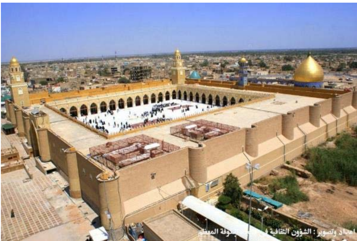
Figure 31. Vue générale de la mosquée aujourd'hui (l'administration de la mosquée)
