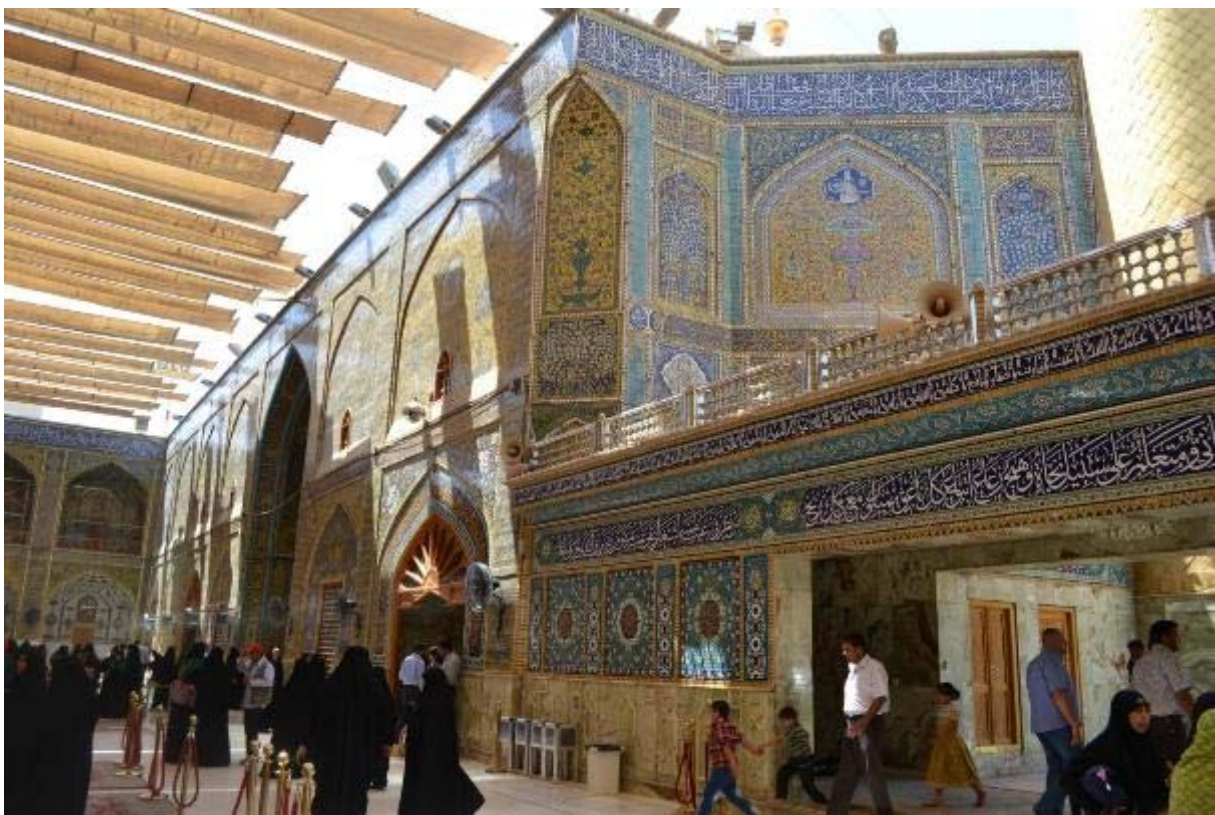
Figure 129: Décor de la façade Nord du Sanctuaire.
