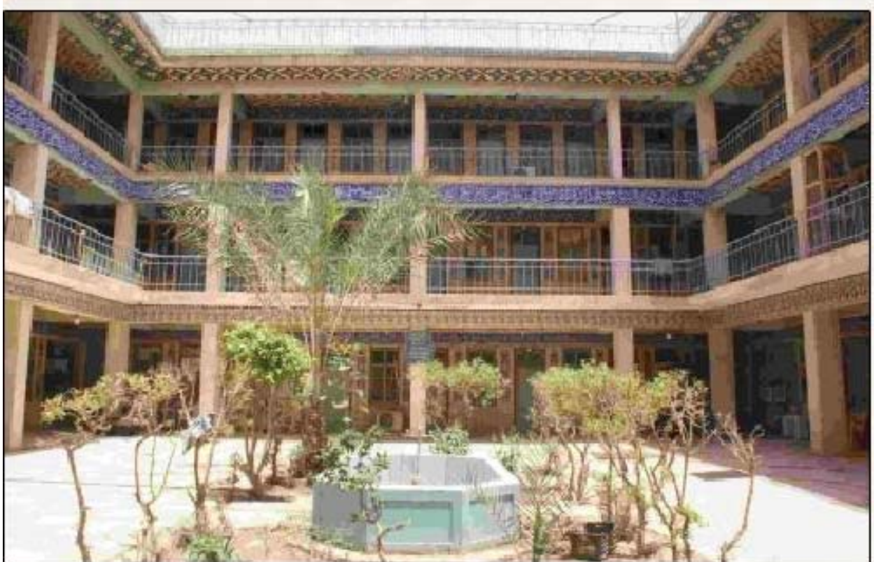
Figure 197: La cour de la Madrasa al- Ākhūnd al-Kubra avant et pendant les travaux (Auteur, Dewan)
