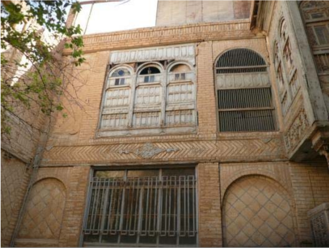
Figure 261 : Les Façade intérieure de la maison Ibn al-Wā 'dī (Dewan)
