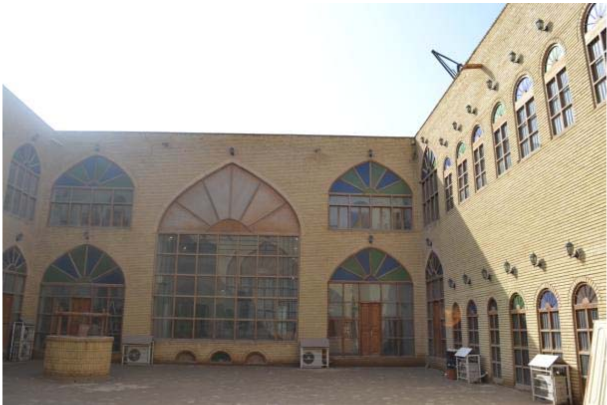
Figure 278 : l. cl. La façade sud du Khān al-Shīlān
