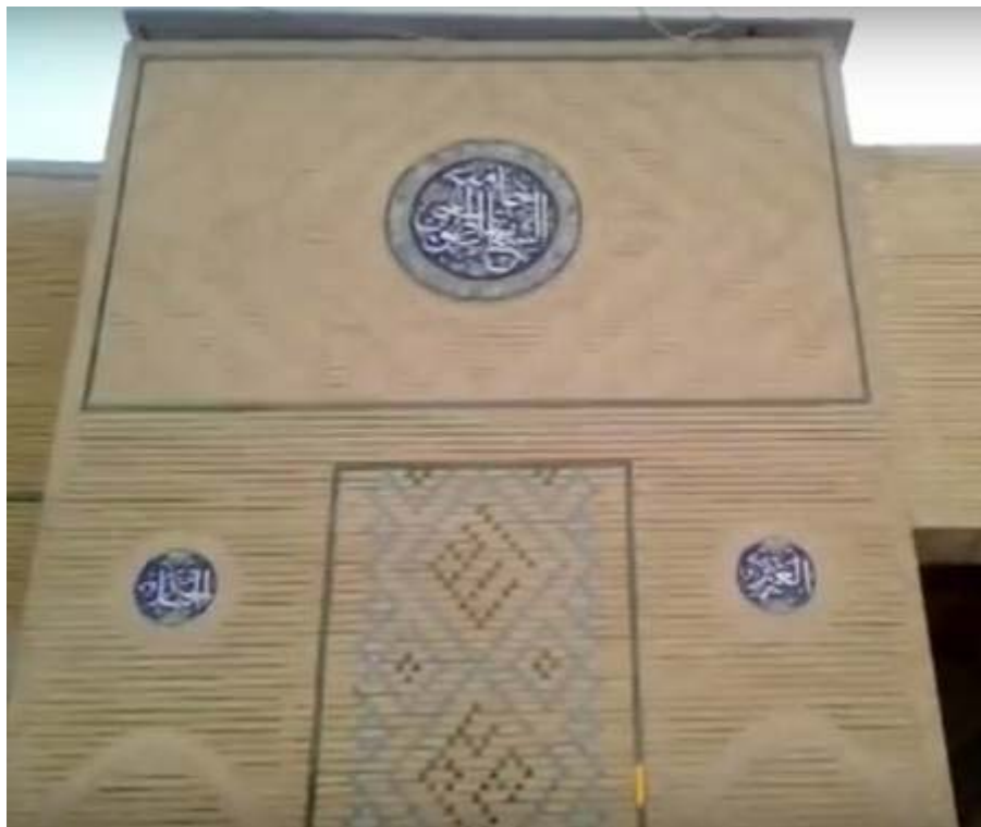
Figure 145: La façade Sud de la mosquée al-Tūsī
