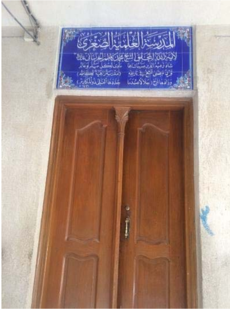
Figure 214: L'entrée d'al-Madrasa al- Ākhūnd al-Suġhrā (Dewan)
