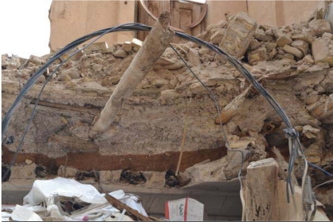
Figure 271 : La composition de la dalle
