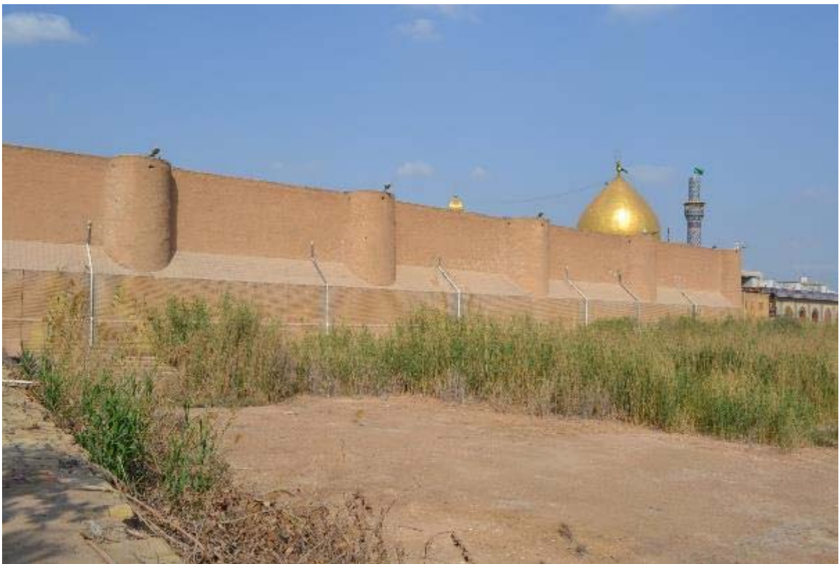
Figure 51. a. Le mur de qibla de la mosquée de côté Qaṣr al-Imāra
