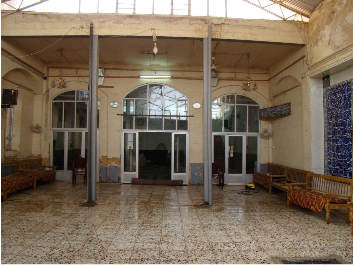
Figure 167: La salle de la mosquée d'al-Jawāhir avant les travaux (Dewan)
