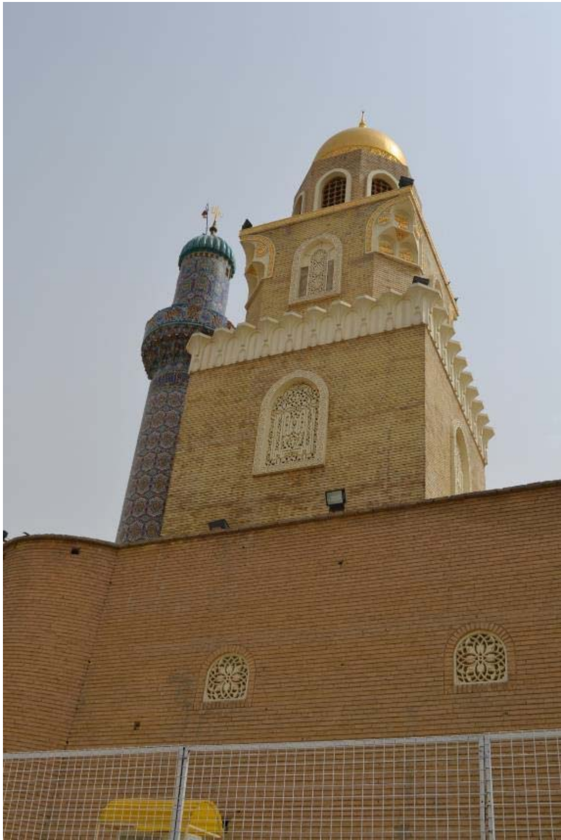
Figure 37. Les deux minarets à l'angle Nord
