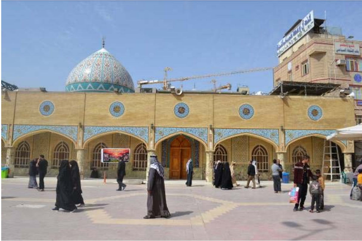
Figure 144: Façade principale de la mosquée al-Tūsī
