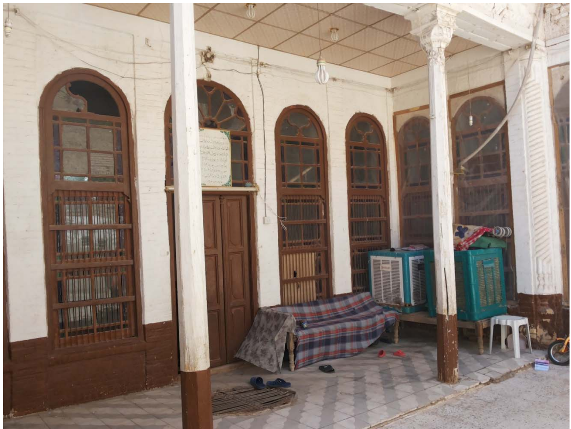
Figure 267 : cl. Exemples de l'espace de la Tarma dans la maison d' al-Yāssarī (IAPN)
