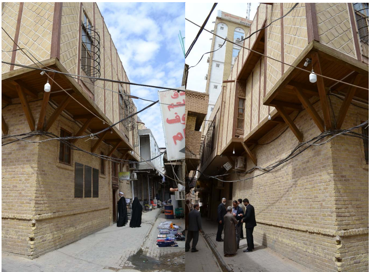
Figure 255 : Les façades extérieures de la maison Hāj Abū Sharba
