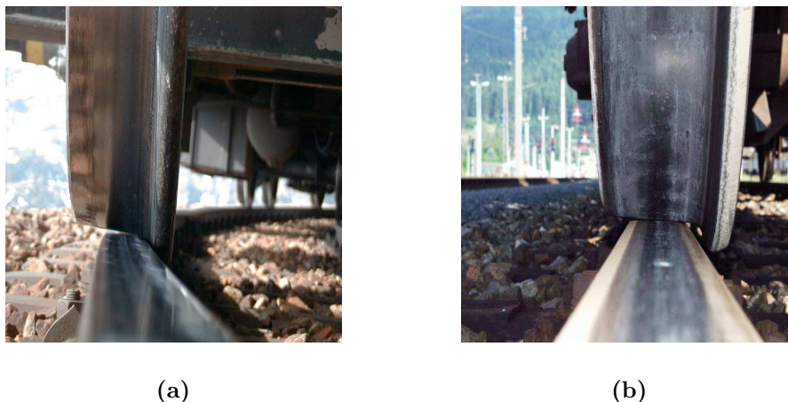
Figure A.5 – (a) Contact roue/rail en courbe, (b) Contact roue/rail en alignement, Trollé (2014).
