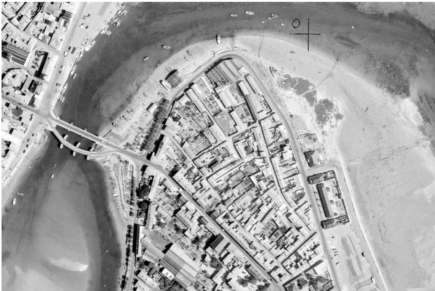
Figure 18 : Vue aérienne de la commune de Croix-de-Vie en 1956. La nouvelle caserne apparaît clairement à la droite de l'image. Source : remonterletemps.ign.fr.
