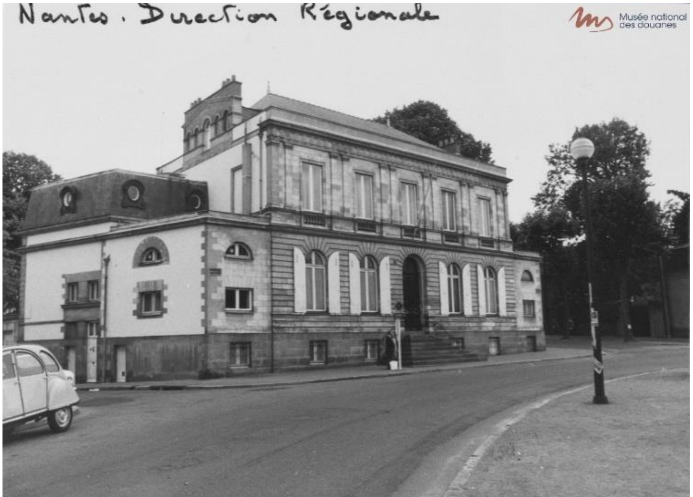
Figure 37 : Hôtel de la direction des douanes de Nantes, 7 place Mellinet. © Musée national des douanes, France.
