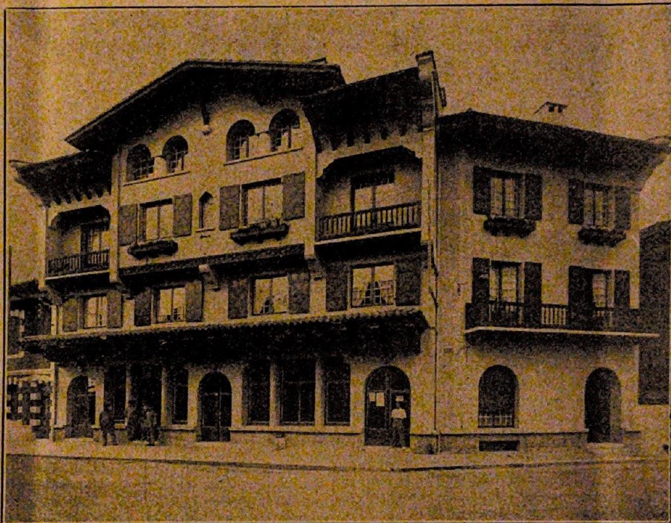
LE BUREAU DE BÉHOBIE A LA FRONTIÈRE FRANCO-ESPAGNOLE Il fait honneur à l'Administration et à l'architecte. Nous souhaitons pouvoir, dans l'avenir, décerner souvent de tels compliments.
