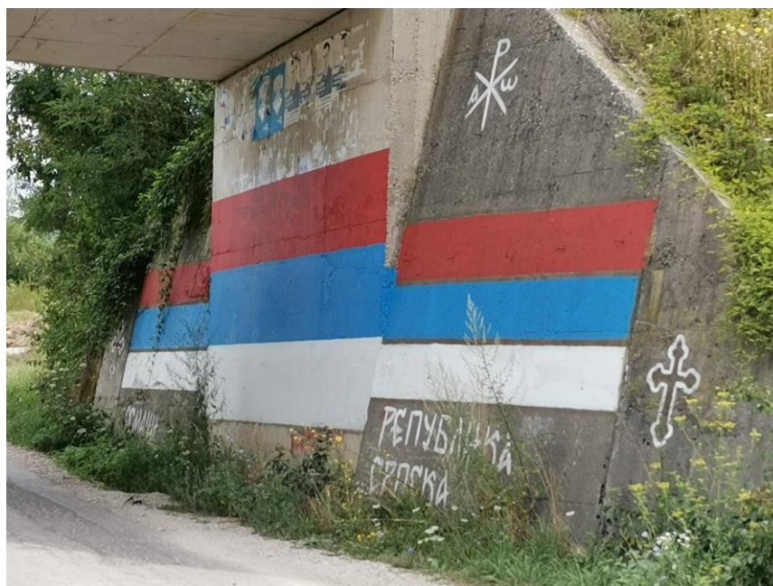
Photographie 22 : Kalesija : Fresque et graffiti entre Osmaci (RS) et Kalesija (FBiH) dans le passage sous la ligne de chemin de fer – 04.08.2021.
