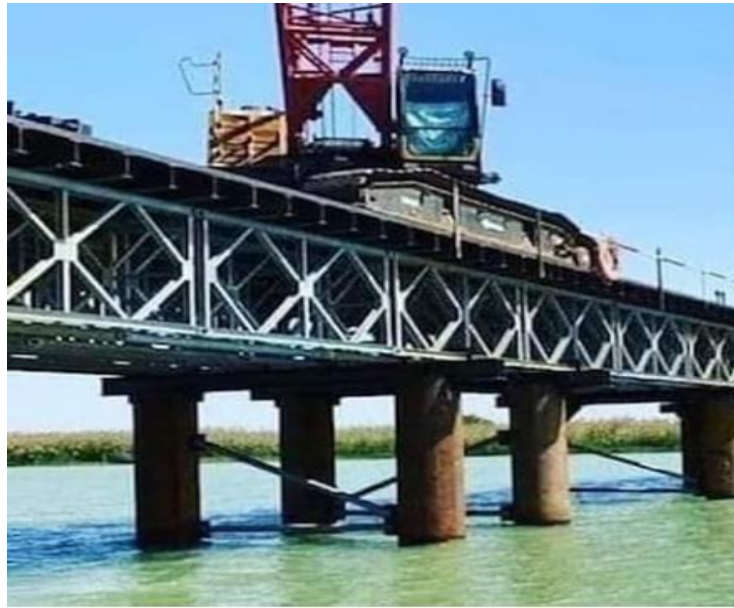
Photo10: Le pont de ROSSO reliant le Sénégal à la Mauritanie
