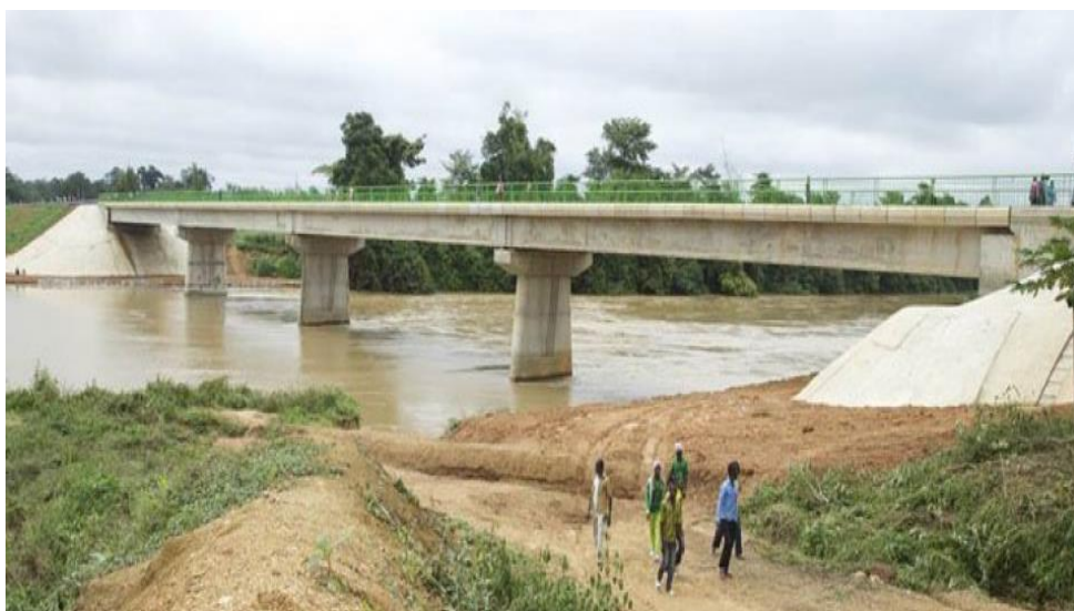
Photo12: Le pont de Bassawa le fleuve Comoé en Côte d'Ivoire
