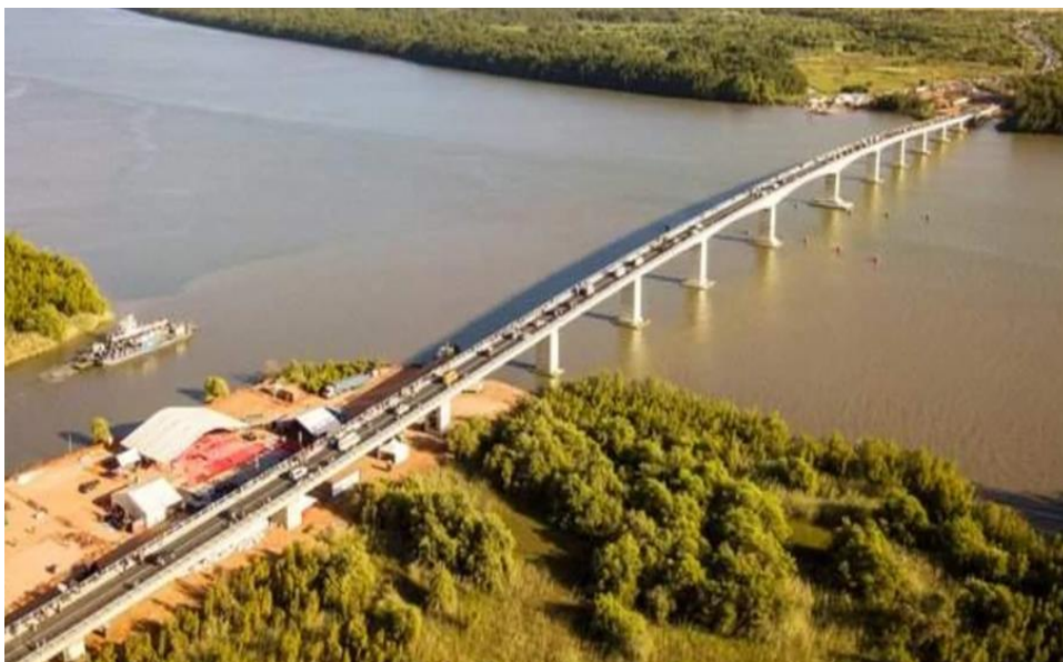
Photo11: Le pont Trans-Gambie reliant la Gambie et le Sénégal
