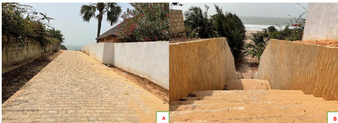
Planche de photos 47 : Réalisation de pavage des corridors et des allées principales vers les hôtels, les résidences (A) et les voies d'accès vers les plages à travers des escaliers de la SAPCO (B) (Bocoum, mars 2022).
