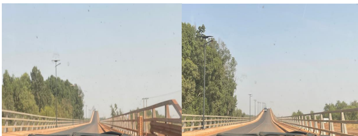
Planche de photos 21 : Réalisation du pont de Farafenni pour le désenclavement la Casamance (Bocoum, mars 2022).
