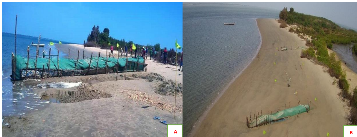
Planche de photos 54 : Construction d'épi sur la flèche de Kafah à l'Ouest (Chevalier, 2019).
