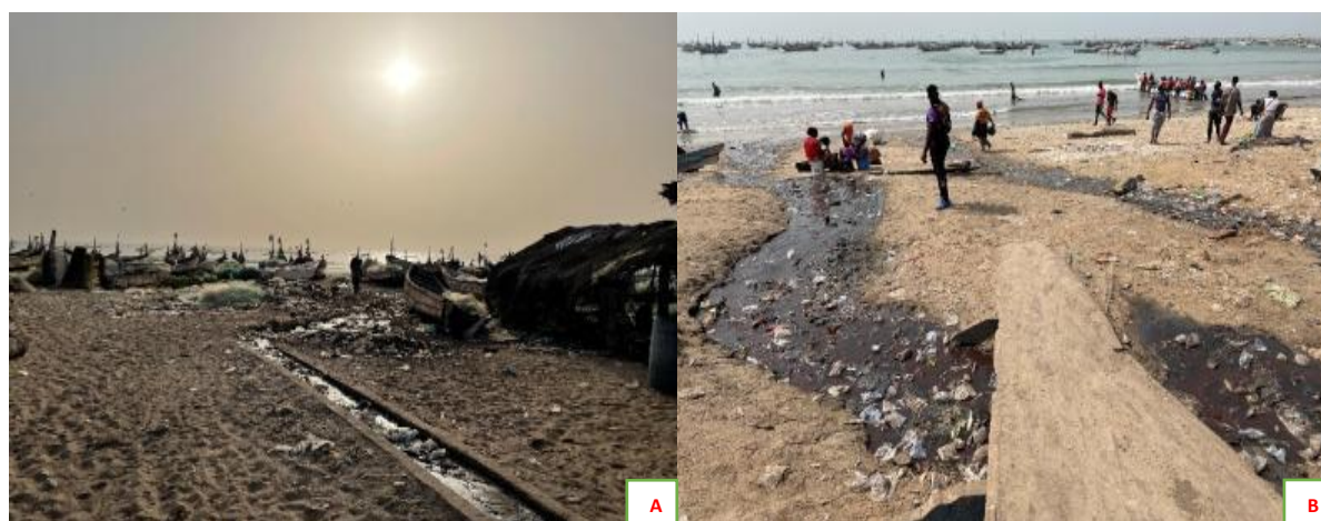
Planche de photos 32 : Canaux d'évacuations des eaux usées à ciel ouvert au Cap Skirring (A) et à Kafountine (B) qui traversent la plage pour se déverser dans l'océan (Bocoum, février et mars 2022).
