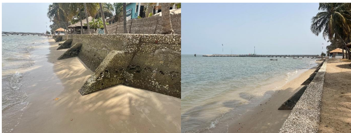
Planche de photos 50 : Murs de protection de l'hôtel Carabane (Bocoum, mars 2022).
