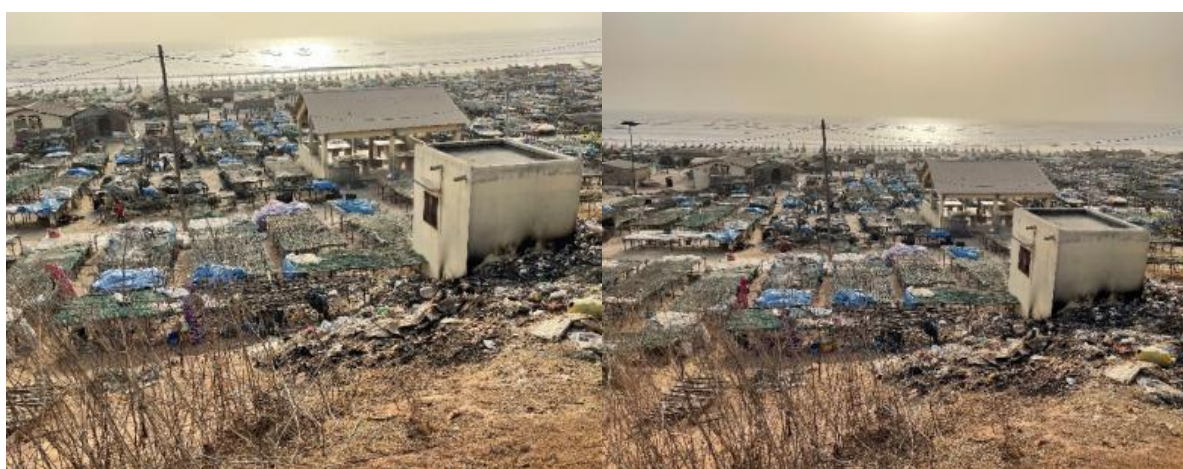
Planche de photos 25 : Zone de transformation de produits halieutiques de Cap Skirring (Bocoum, mars 2022).
