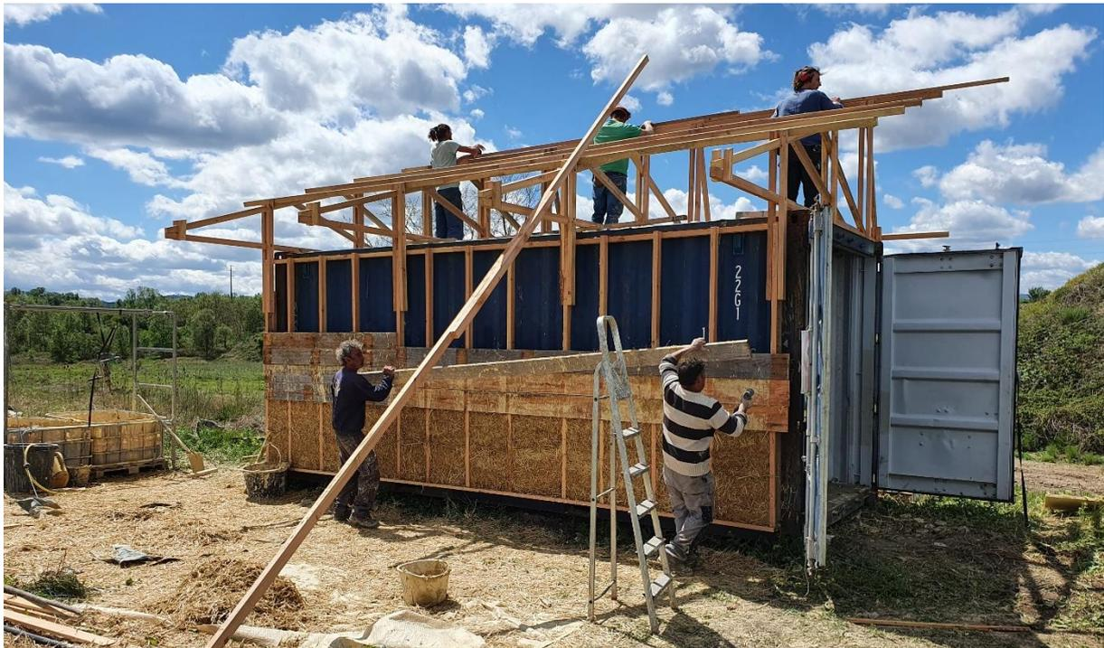
Figure 31 : Chantier ‘briques en terre crue’, un travail en équipe entre la Régie et Rural Combo.
