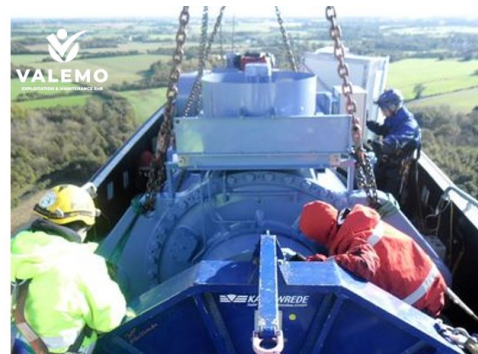
Figure 4.2: Photos d'une intervention de remplacement d'une multiplicatrice d'éolienne
