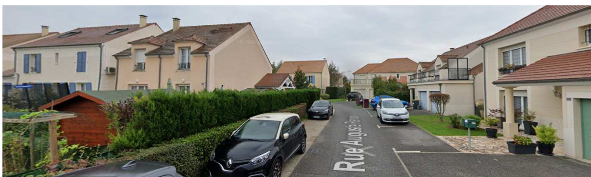
Figure 40: Lotissement en raquette de la rue Auguste Renoir à Bussy-Saint-Georges (Google Street view, octobre 2022)
