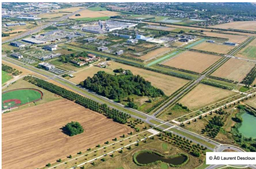
Promenade piétonne de 5 km entre deux forêts, l'allée royale, au premier plan, tangente le carré d'1,4 km qui délimite le centre d'agglomération de la ville nouvelle de Sénart.
