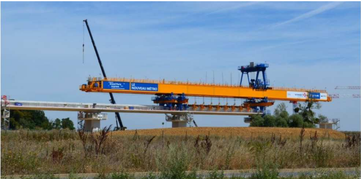
Figure 59: Poutre de lancement du chantier de la ligne 18 (Faussabry, 2023)
