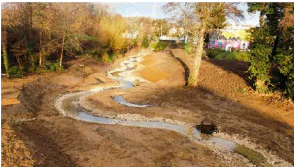
Figure 123: Travaux de reméandrage du ru de Vauhallaan (SIAVB, 2022)
