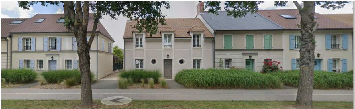
Figure 44: Les maisons du cahier des charges Disney à Bailly-Romainvilliers (Google street view, 2022)
