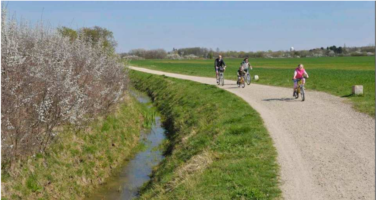
Figure 31: Rigole de Corbeville (site officiel EPA Paris-Saclay)
