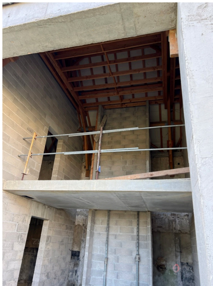
Figure 110: Travaux de consolidation du mur d'enceinte depuis l'intérieur de la friche (M. Jussaume, 2023)
