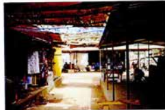
Marché de Gaoua après reconstruction.
