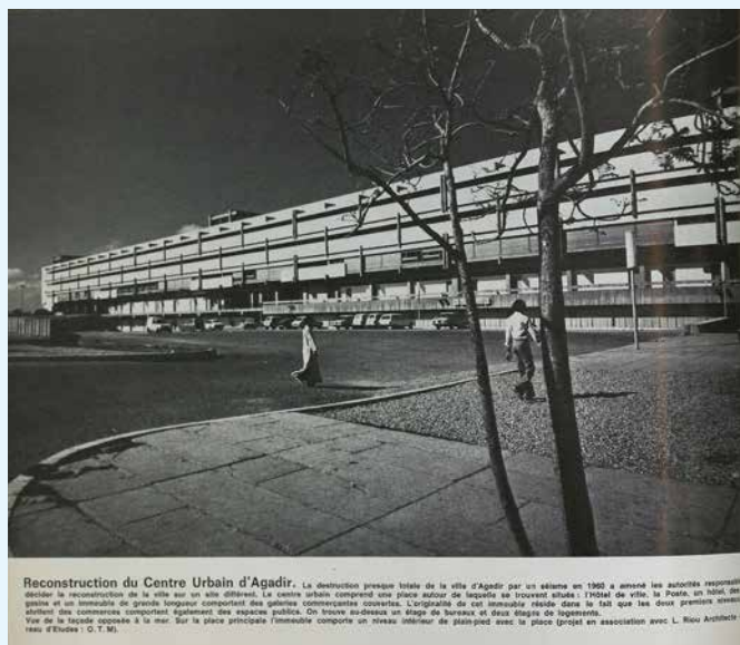
Fig. 3 à 5. Planches extraites de Henri Tastemain, Eliane Castelnau : réalisations, 1950-1974 , Chiasso, Ed. Score, vers 1975. A gauche : Institut national agronomique Hassan II à Rabat. En bas : Reconstruction du centre urbain d'Agadir après le séisme de 1960.
