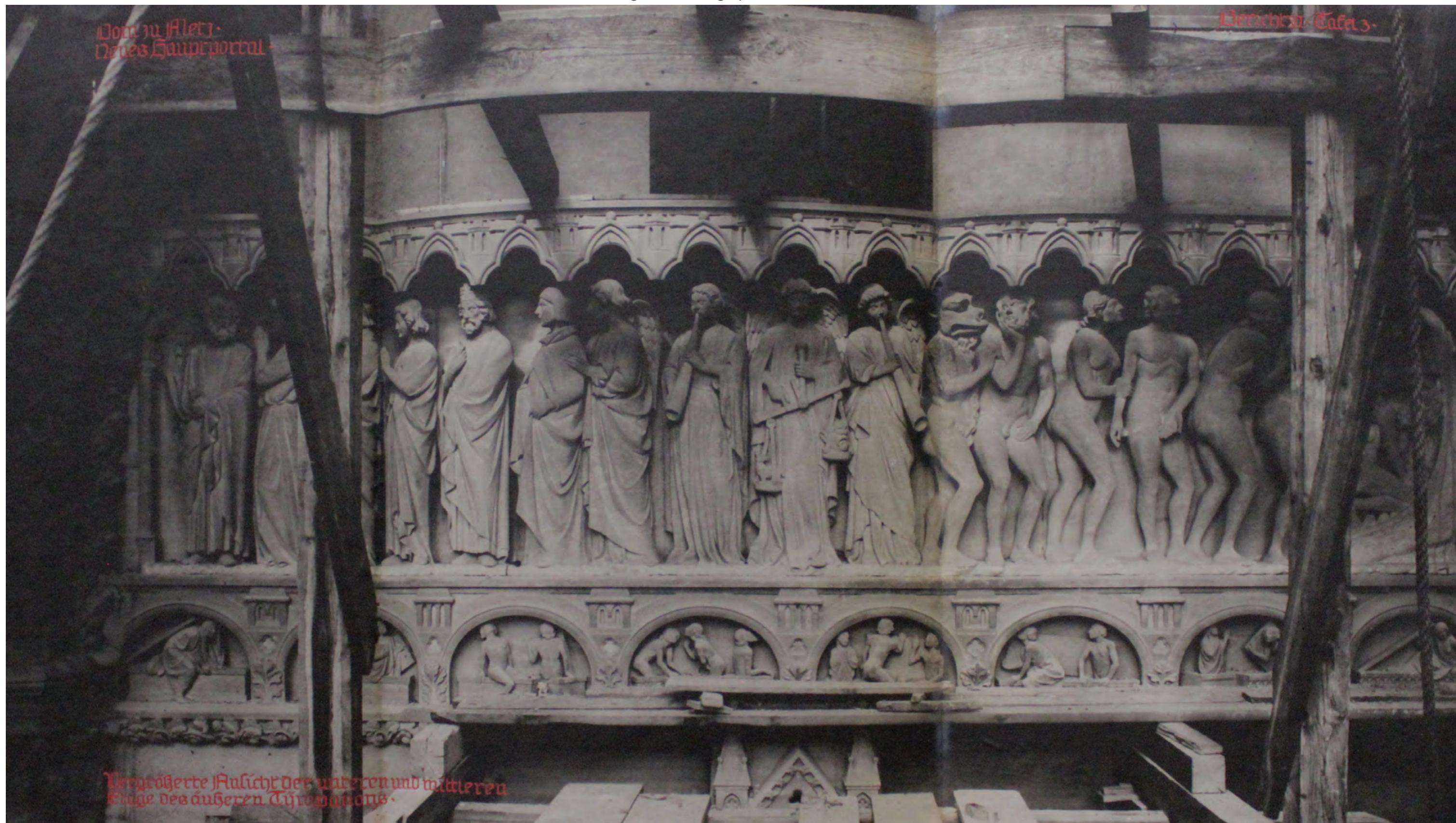
Fig. 122 : Photographie de chantier
