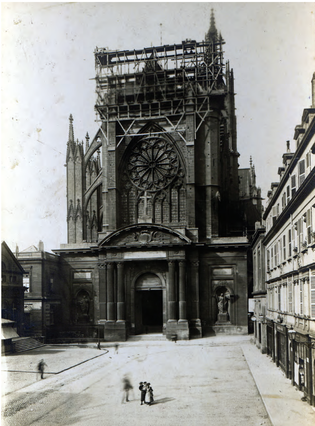
Fig. 79 : Façade principale en travaux
