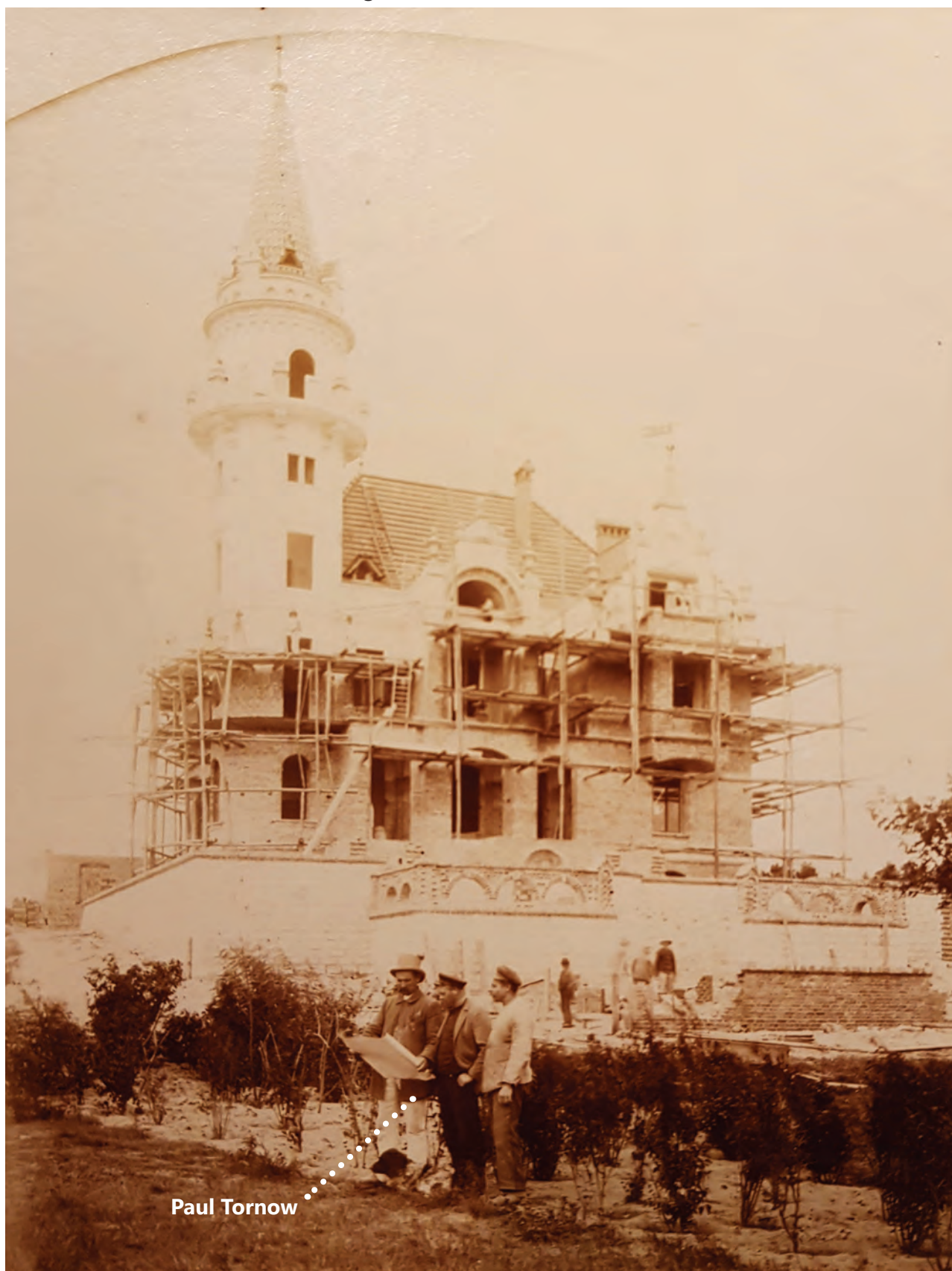
Fig. 24 : Chantier d'une villa
