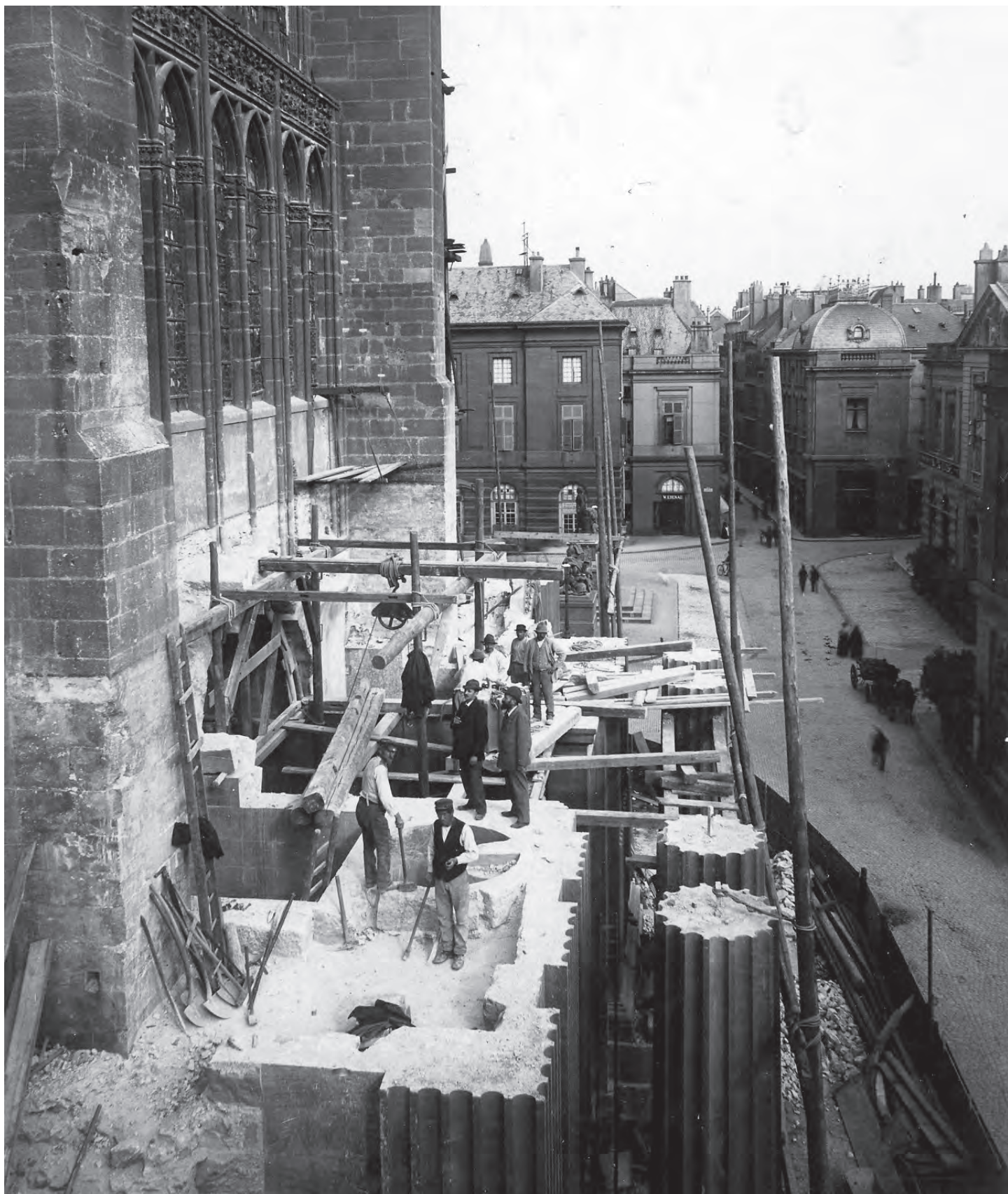
Fig. 47 : Démontage du portail de J.-F. Blondel
