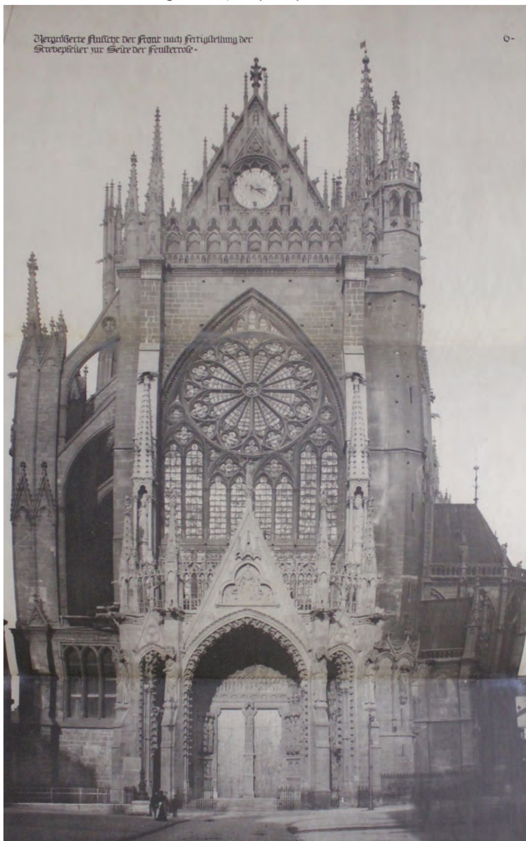
Fig. 58 : Façade principale achevée
