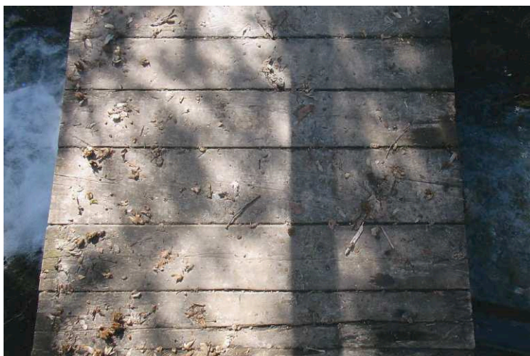
Photo n°5 : Le pont qui fait obstacle , 2017
