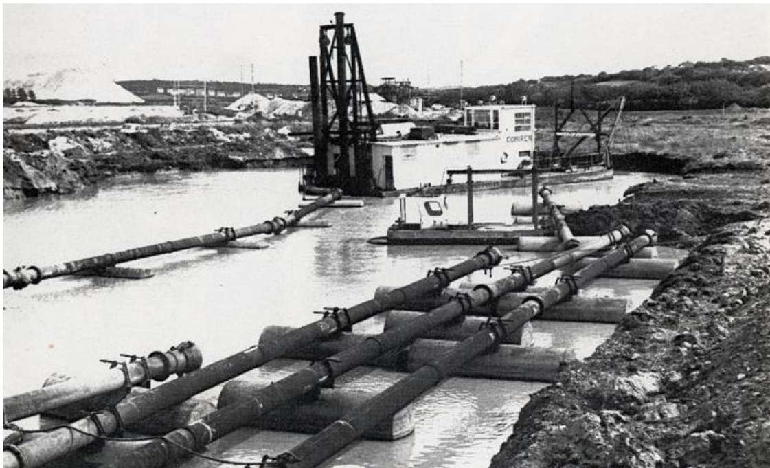
Figure 18 : Drague utilisée dans le cadre de l'exploitation de l'étain alluvionnaire à Saint Renan dans les années 1960. Source de l'image : http://www.expotem.fr/2011/08/la-comiren/
